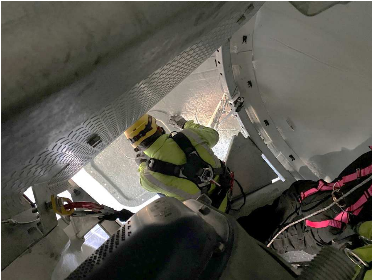
Abbildung 7.29: Ausbau der Spinnerluke
