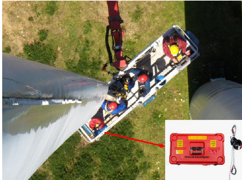
Abbildung 10-1: Beispiel für einen Notabstieg an einem Mannkorb
