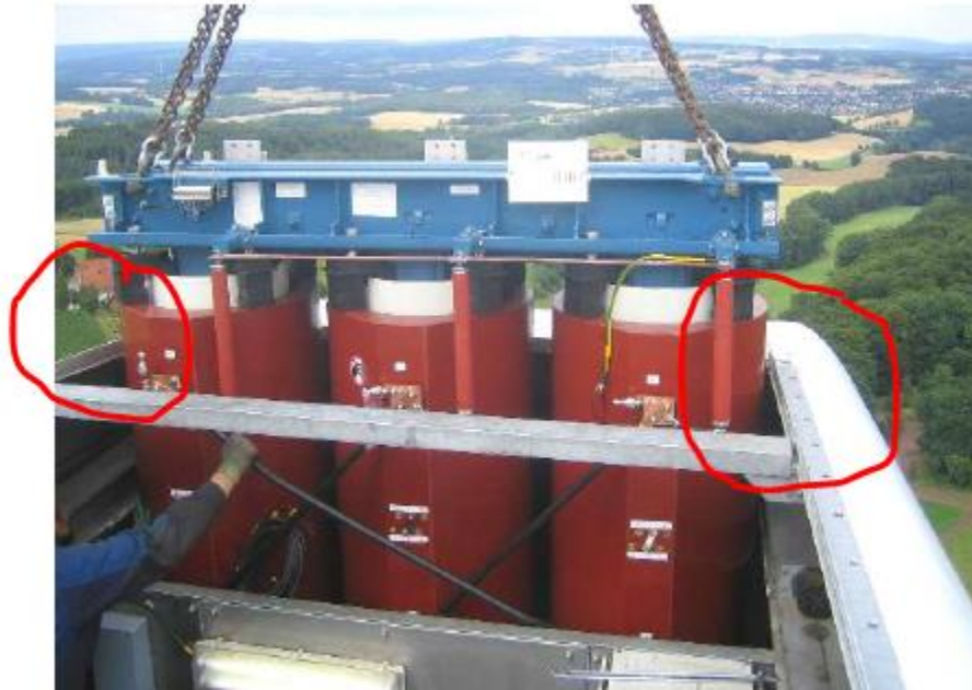
Abbildung 18-1: Führen des Transformators in das Maschinenhaus
