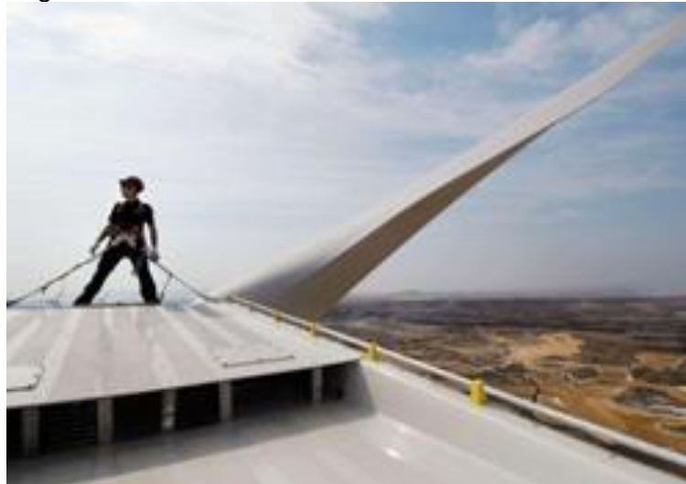
Abbildung 10-2: Arbeiten auf dem Maschinenhaus
