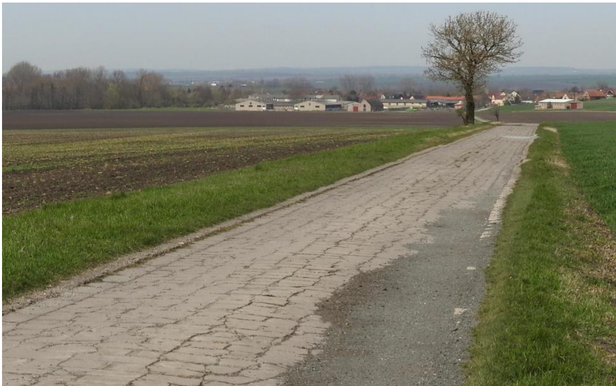
Abbildung 11: Betonweg im UG in Richtung Werningshausen
