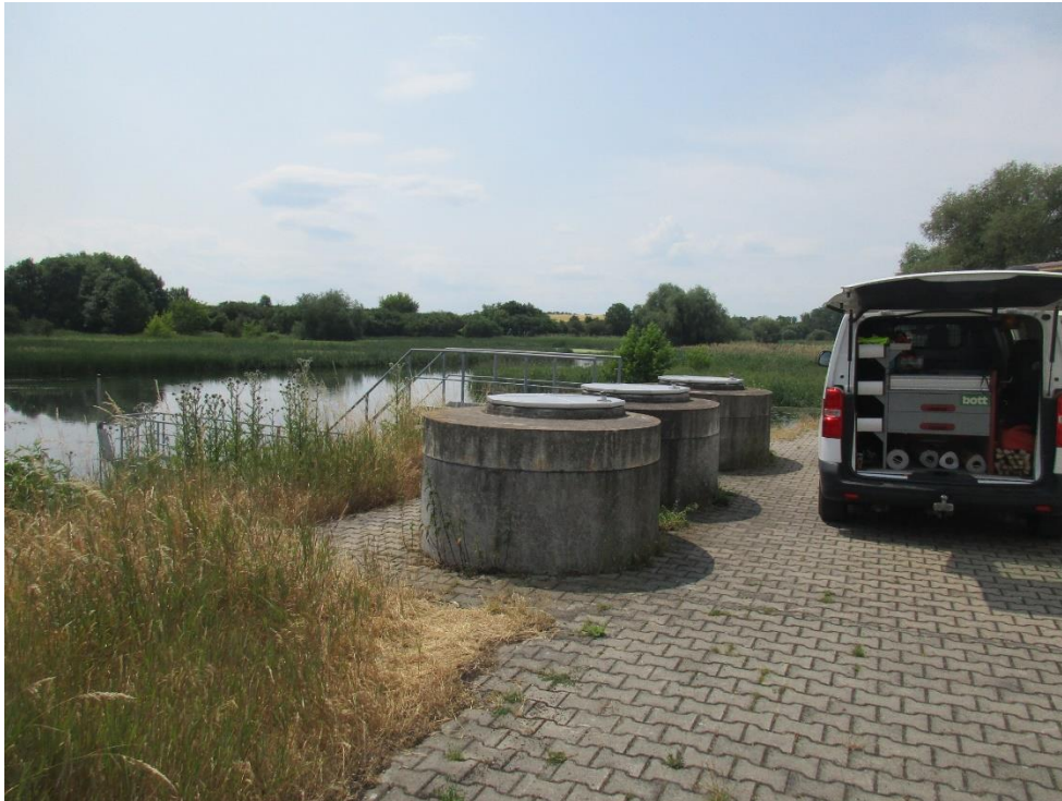
Abbildung 6: Aufsatzschächte Heberventile, Unstrut im Hintergrund – Bild während Teildauerstau aufgenommen
