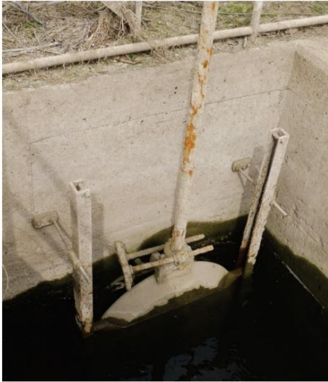
Abbildung 18: Spindelschieber und Bediensteg der bestehenden Sielleitung
