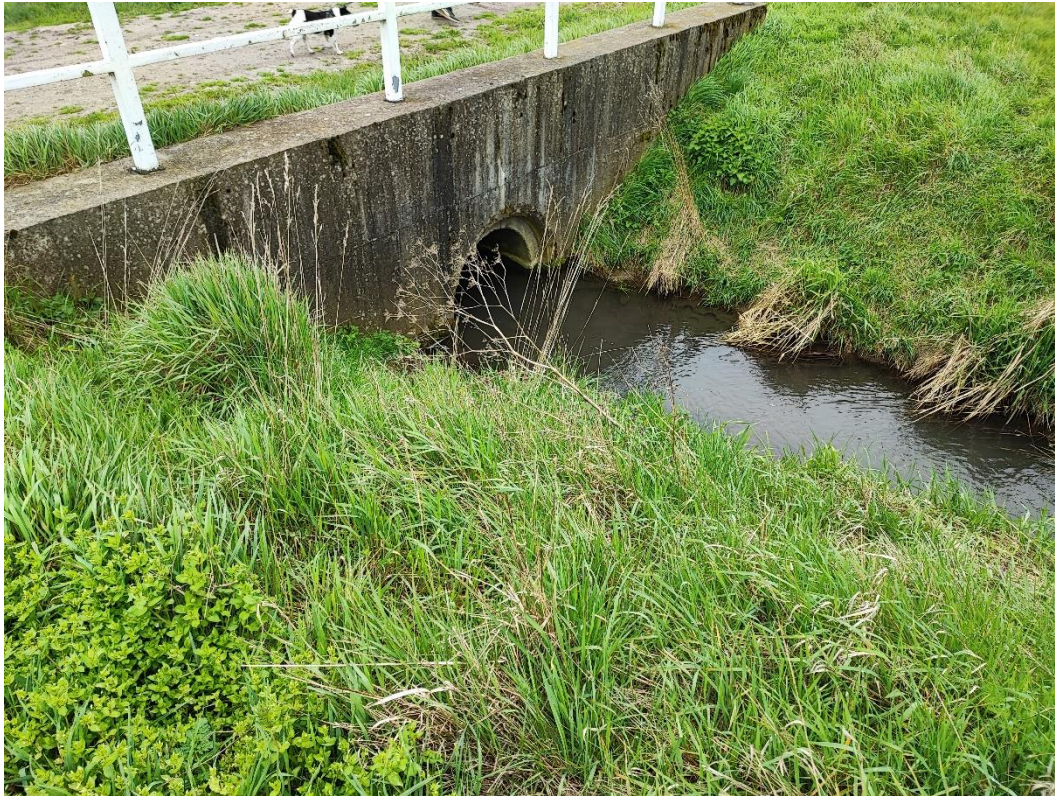
Abbildung 28: Einlauf in den Durchlass für Überfahrt über Öde, 170 m stromaufwärts der Einmündung Mittelgraben
