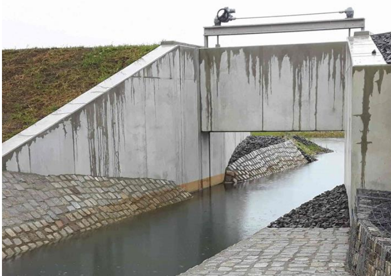
Abbildung 15: vergleichbares Durchlassbauwerk am Wiesenbach (HWS Elster)
