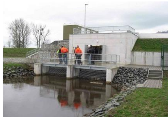
Abbildung 28: vergleichbares Schöpfwerk zur Binnenentwässerung des Wiesenbaches (HWS Elster)
