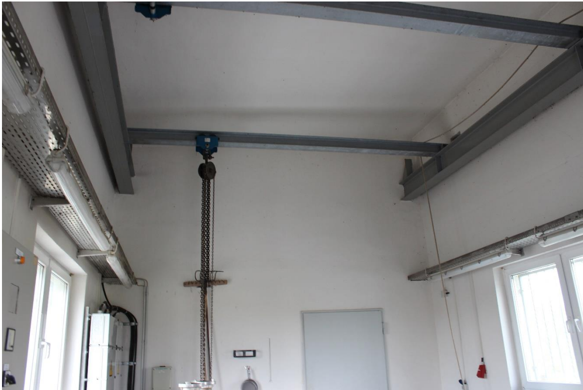
Abbildung 12: Innenraum oberer Teil Schöpfwerk mit Laufkran zum Einheben der Pumpen
