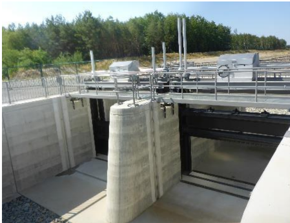
Abbildung 16: Verschlüsse mit steigenden Spindeln
