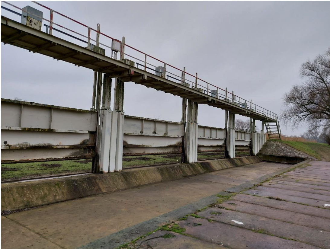
Abbildung 19: Durchlassbauwerk mit Tosbecken, gepflasterte Böschung als Anschluss an Unstrut Eindeichung – Blickrichtung Südwesten
