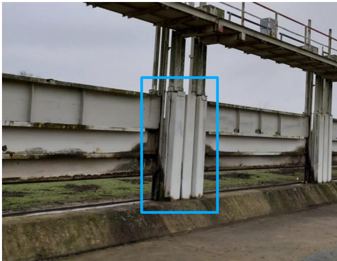
Abbildung 11: bestehende Spundwandpfeiler am DLBW
