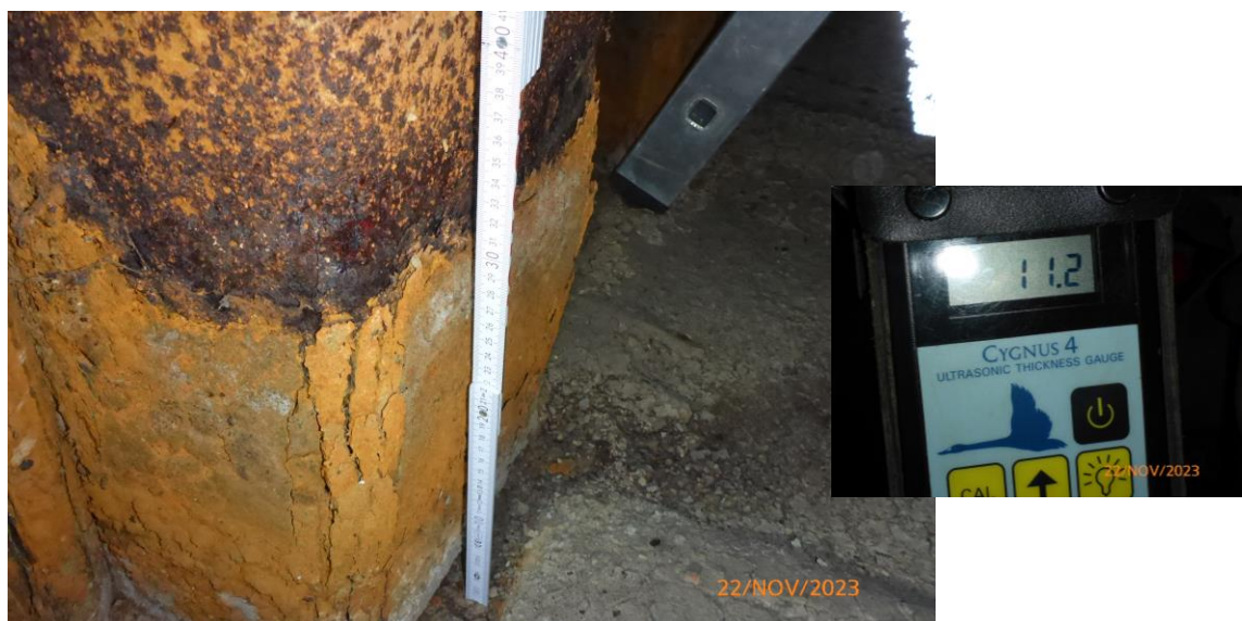
Abbildung 9: Spundwandkorrosion und Restwanddickenmessung
