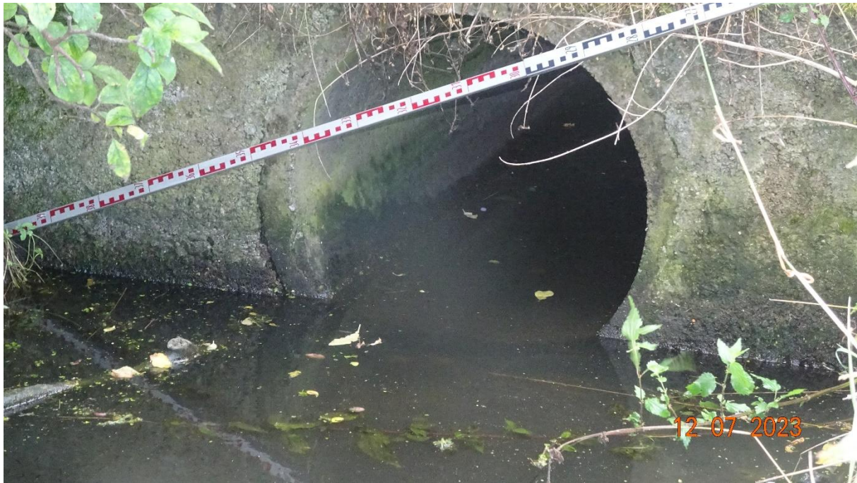
Abbildung 5: Auslaufrohr bei Henschleben, Teildauerstau steht an
