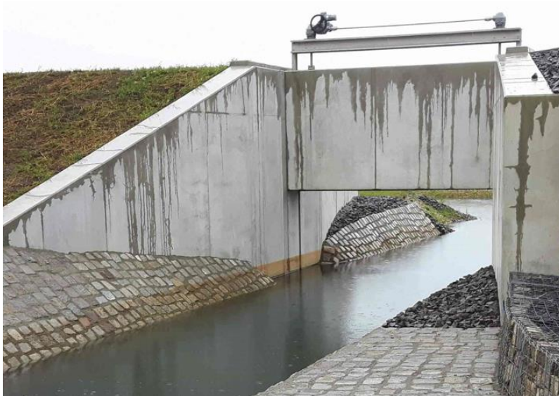
Abbildung 25: vergleichbares Durchlassbauwerk am Wiesenbach (HWS Elster)
