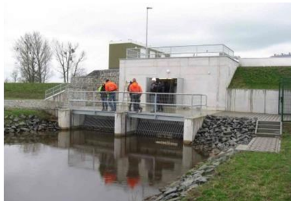
Abbildung 18: vergleichbares Schöpfwerk zur Binnenentwässerung des Wiesenbaches (HWS Elster)
