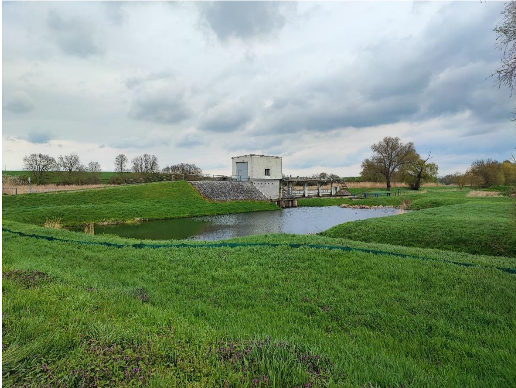
Abbildung 1: Schöpfwerk Henschleben II mit Mahlbusen und Auffahrt zum oberen Teil sowie Durchlassbauwerk (rechts daneben) – Bild vom Nebendamm aufgenommen, Blickrichtung Süden
