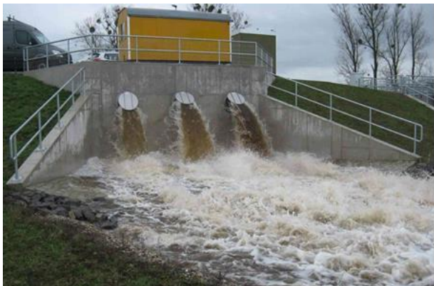
Abbildung 28: vergleichbares Schöpfwerk zur Binnenentwässerung des Wiesenbaches (HWS Elster)
