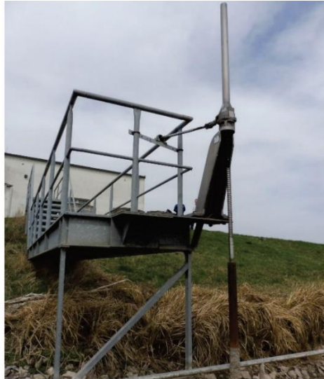
Abbildung 18: Spindelschieber und Bediensteg der bestehenden Sielleitung
