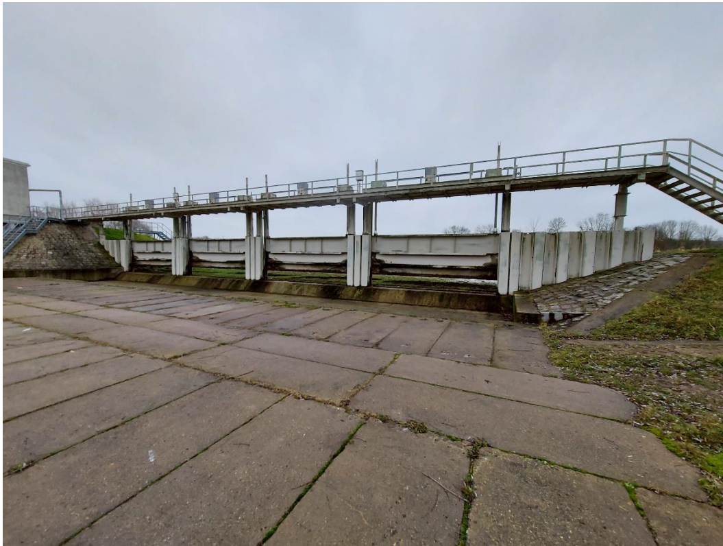
Abbildung 18: Blick auf das Durchlassbauwerk mit Tosbecken davor – Bild aus Richtung Hochwasser-Schutzraum II in Richtung Süden aufgenommen
