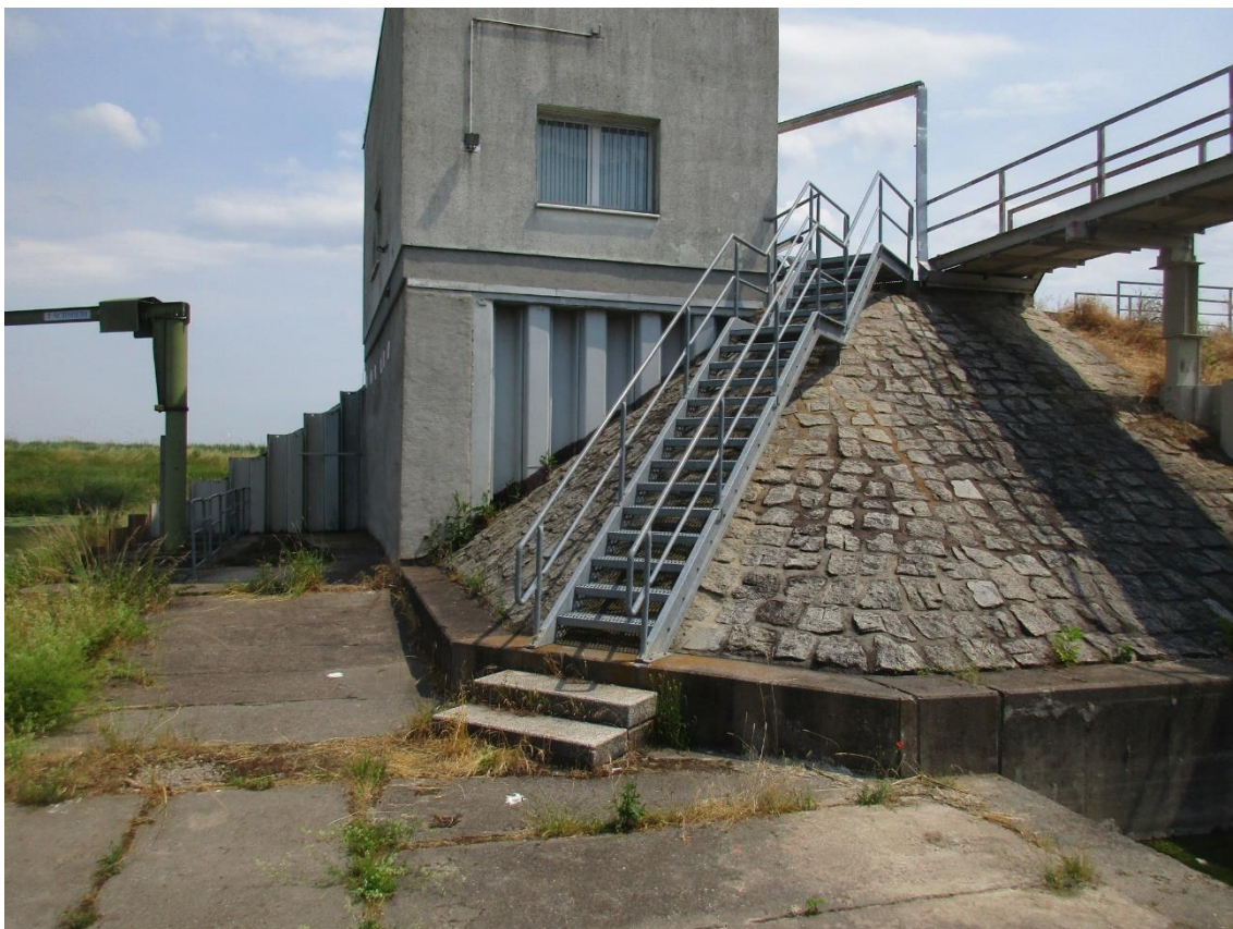
Abbildung 13: Westansicht des Schöpfwerkes mit Hebegerät am Einlaufbauwerk und Stahltreppe um oberen Teil Schöpfwerk bzw. Übergangssteg Durchlassbauwerk zu erreichen
