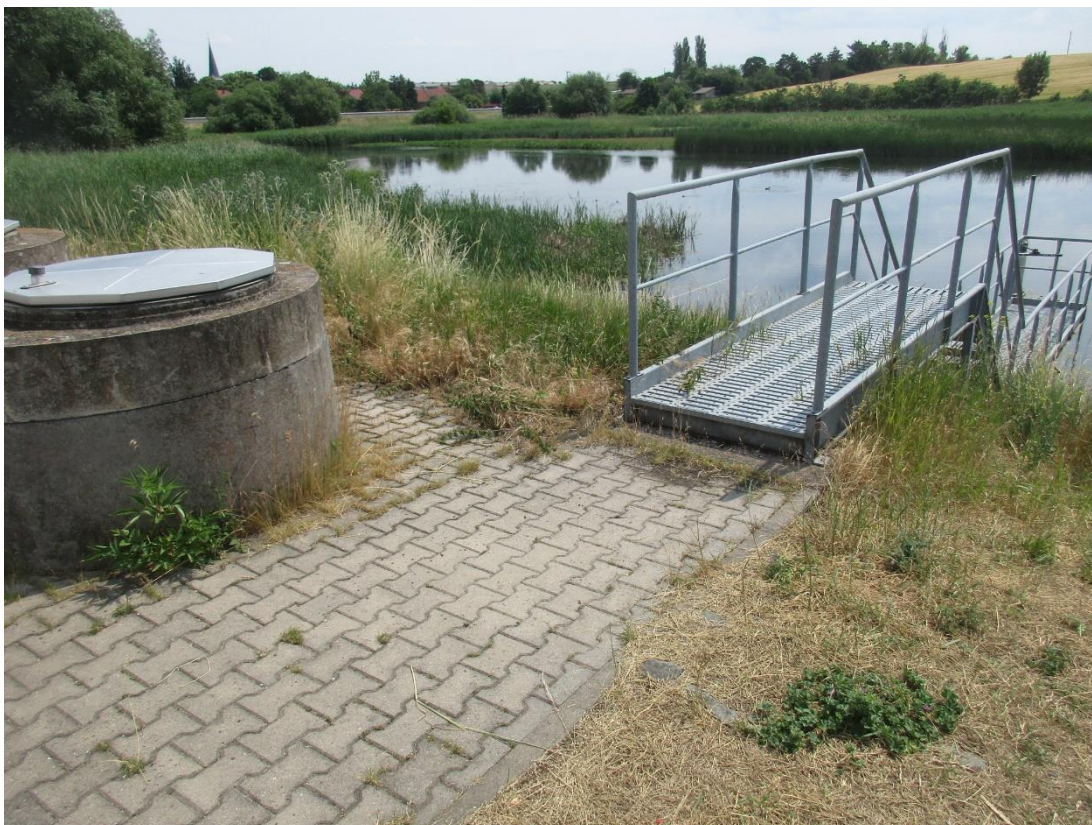
Abbildung 7: Bediensteg zum Schieberverschluss Sielleitung des Schöpfwerkes
