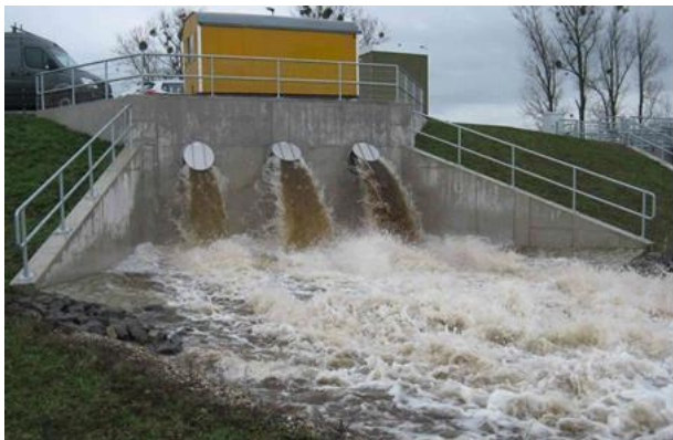
Abbildung 18: vergleichbares Schöpfwerk zur Binnenentwässerung des Wiesenbaches (HWS Elster)
