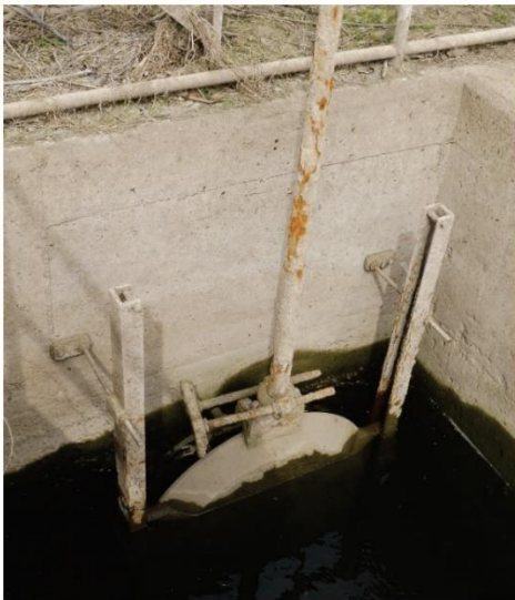
Abbildung 14: Spindelschieber und Bediensteg der bestehenden Sielleitung
