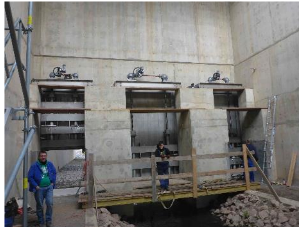
Abbildung 17: Verschlüsse mit nicht-steigenden Spindeln
