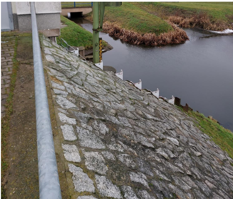
Abbildung 5: befestigte Böschung vom Eingang oberer Teil Schöpfwerk in Richtung Mahlbusen
