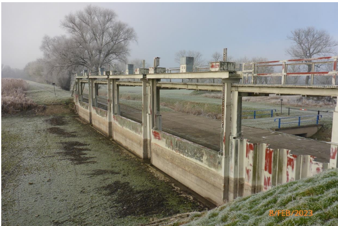
Abbildung 20: Schütztafeln des Durchlassbauwerkes, Seite Unstrut
