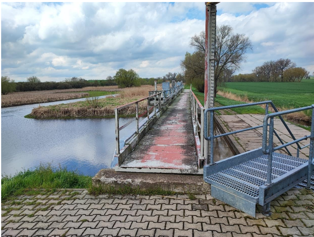
Abbildung 15: Zugang von oberem Teil Schöpfwerk zum Übergangssteg Durchlassbauwerk und zur Stahltreppe in Richtung Tosbecken
