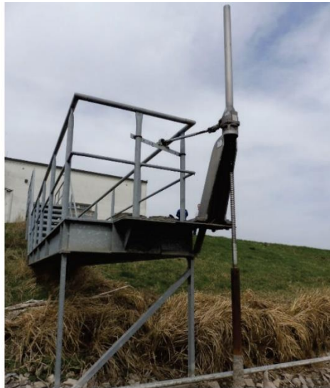
Abbildung 14: Spindelschieber und Bediensteg der bestehenden Sielleitung
