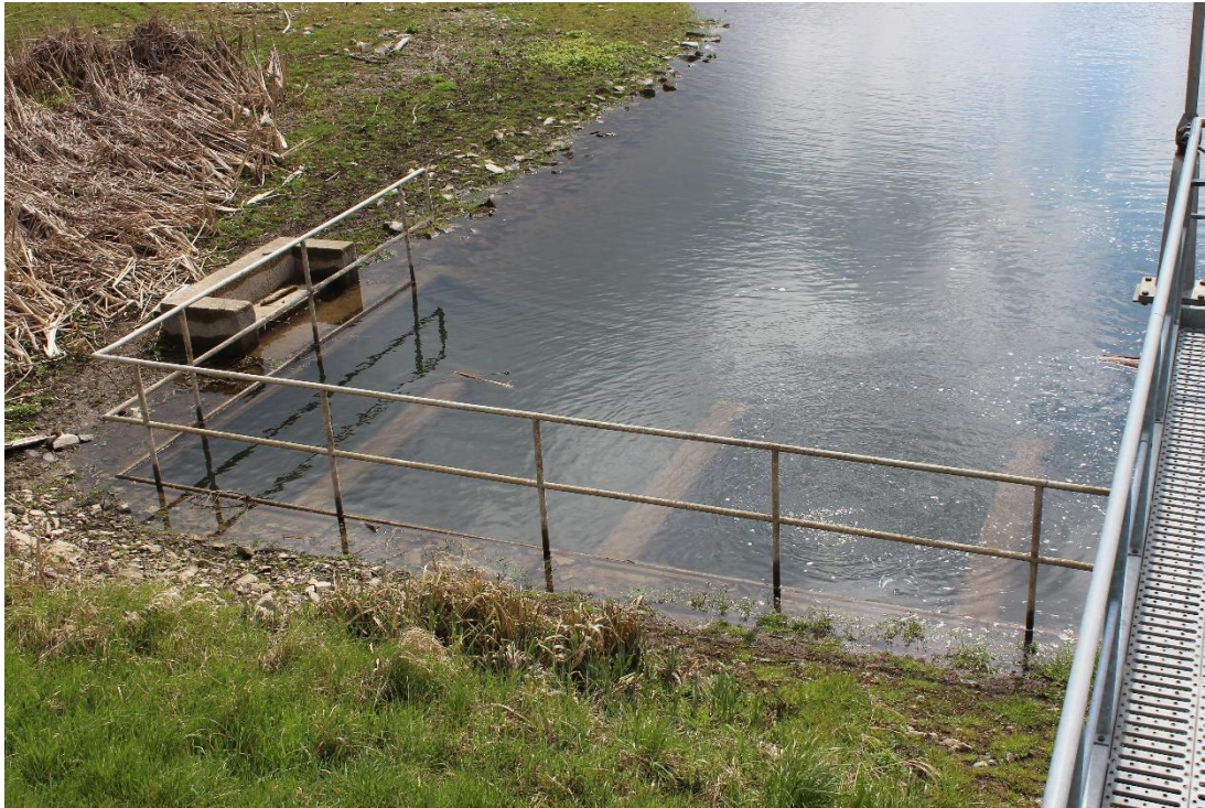
Abbildung 8: Auslaufbauwerk zur Unstrut, 1 kleines Feld sowie 2 große für die Pumpen, ein weiteres für die Sielleitung rechts – Bild während Anstauen für den Teildauerstau aufgenommen
