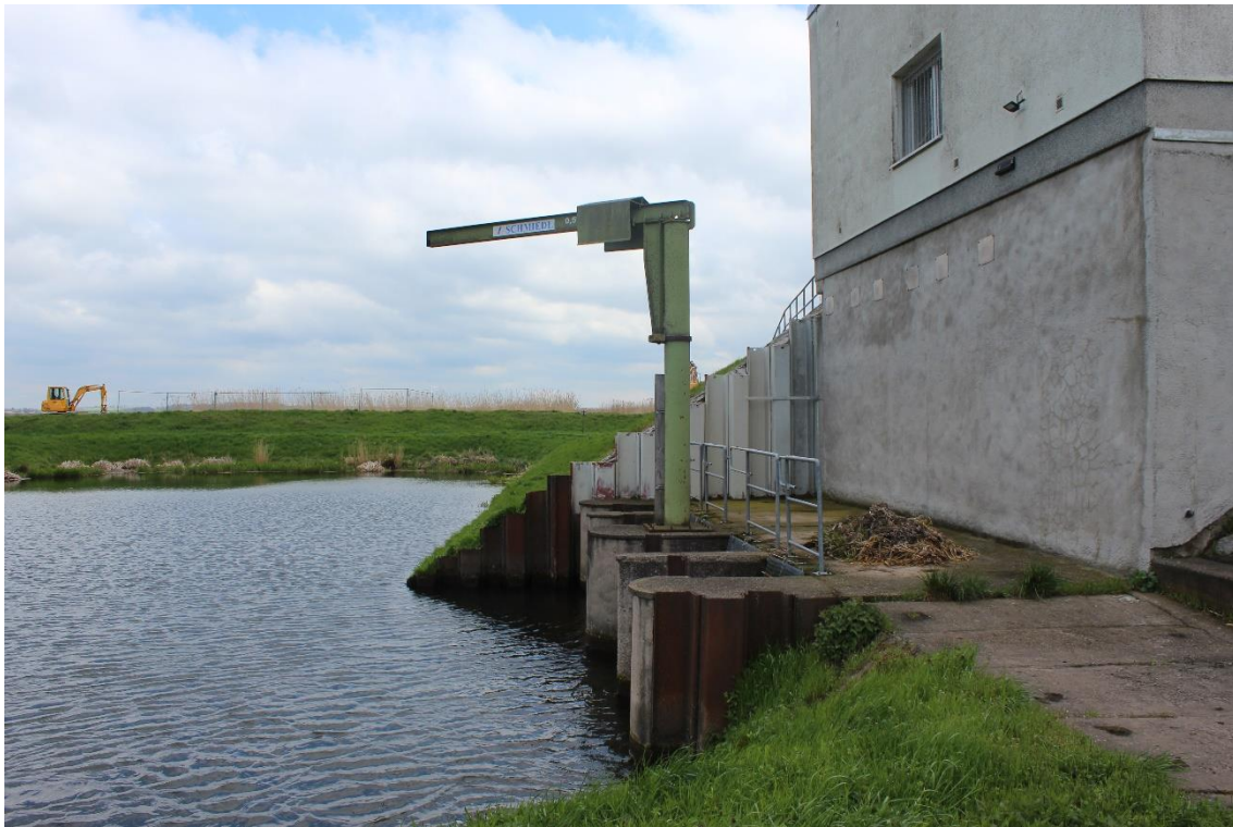
Abbildung 14: Mahlbusen und Einlaufbauwerk Schöpfwerk
