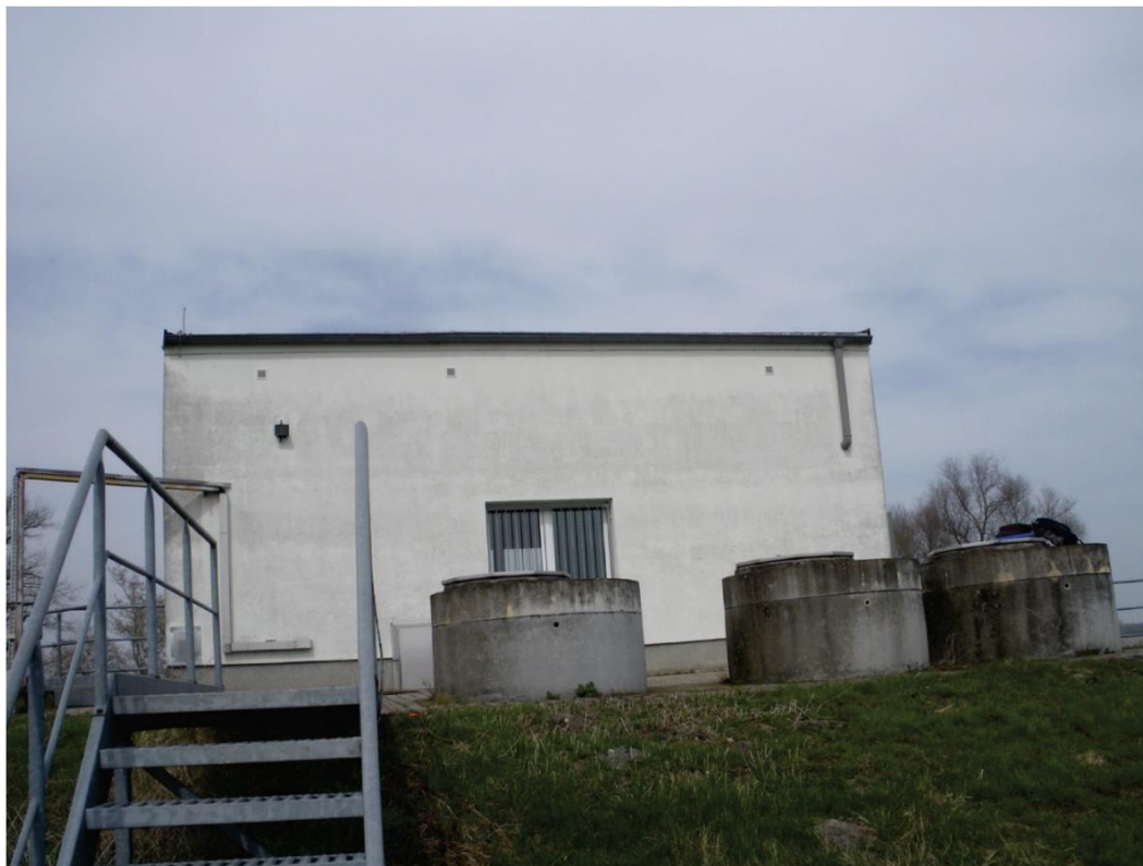
Abbildung 9: Südansicht oberer Teil Schöpfwerk und Aufsatzschächte Heberventile – Bild vom Bediensteg zum Schieberverschluss Sielleitung aufgenommen
