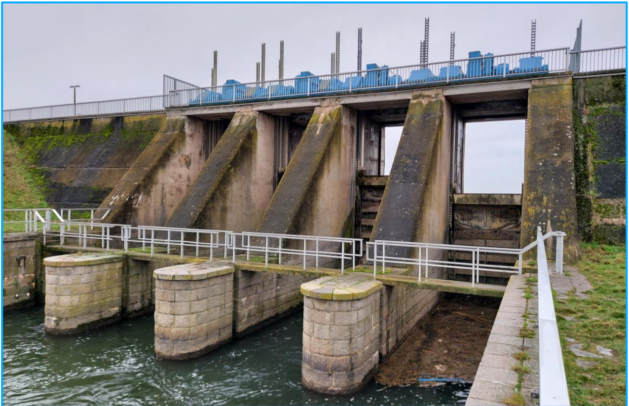
Blick vom Tosbecken auf das Abschlussbauwerk
