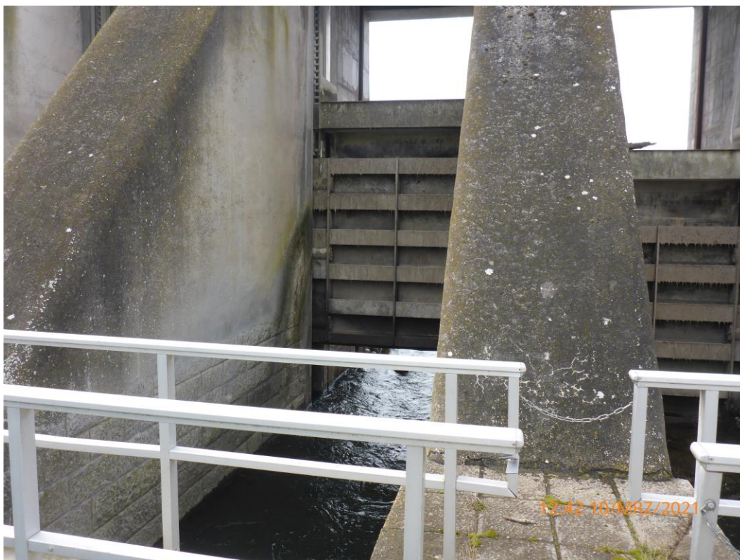
Abbildung 6: Wehrfelder mit Schütztafeln von Unterstrom, Blickrichtung Westen
