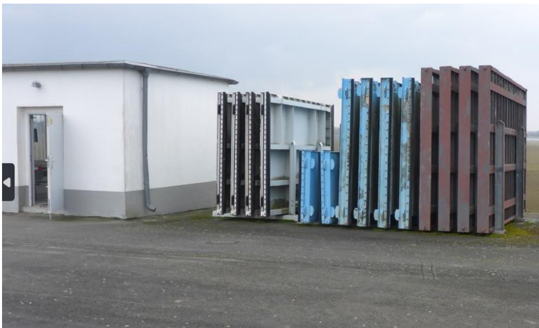
Abbildung 8: Steuerbox TO11-ABW (links) und Lagerort für Dammtafeln und Rechen (rechts)
