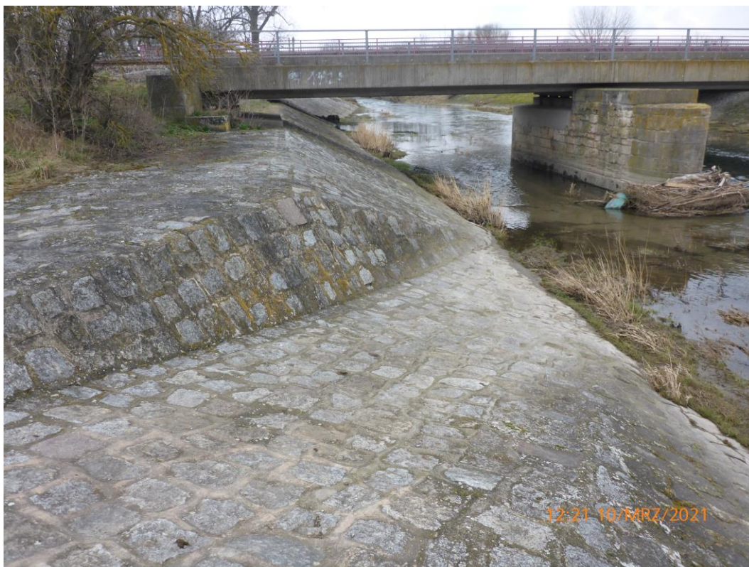
Abbildung 13: Zufahrtsrampe zu Brückenpfeilern der Eisenbahn- und Straßenüberführungen aus Pflaster in Beton, Aufnahme von Schacht Abgabepegel nach Brücken, Blickrichtung Osten
