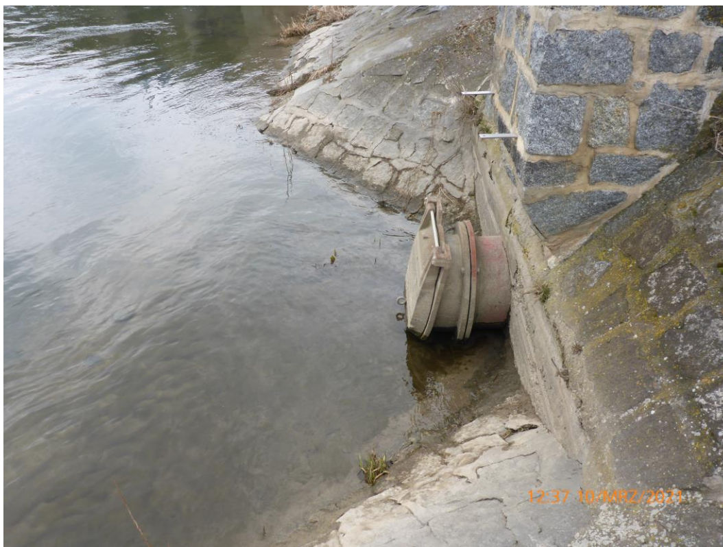
Abbildung 9: Auslauf nördliche Entwässerungsleitung mit Rückstauklappe im Auslaufbereich des Ab-sperrbauwerks, Entwässerung der Verkehrsfläche und Böschung des Hauptdammes in die Unstrut, Blickrichtung Westen
