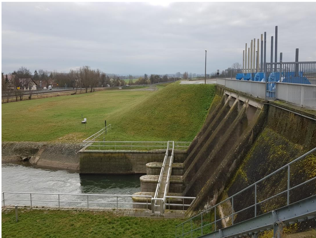
Abbildung 8: Abschlussbauwerk im Auslaufbereich mit Zugangstreppe, Wehrpfeilern und Bediensteg, Blickrichtung Süden
