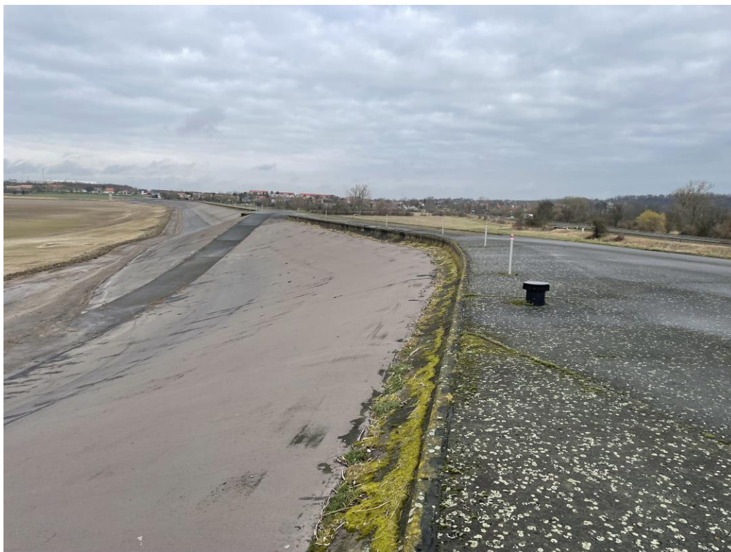
Abbildung 9: Auslauf nördliche Entwässerungsleitung mit Rückstauklappe im Auslaufbereich des Ab-sperrbauwerks, Entwässerung der Verkehrsfläche und Böschung des Hauptdammes in die Unstrut, Blickrichtung Westen
