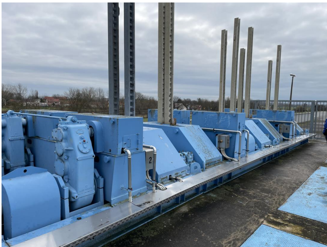
Abbildung 5: Abschlussbauwerk mit Antrieb für Wehrverschlüsse, Zaun- und Toranlage, Blickrichtung Süd-Osten
