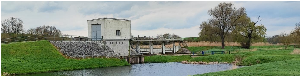
Abbildung 12: Bestehendes Schöpfwerk Henschleben II mit Durchlassbauwerk
