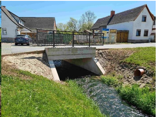
Fl.-km 3+870 (drei aufeinanderfolgende Durchlässe)
