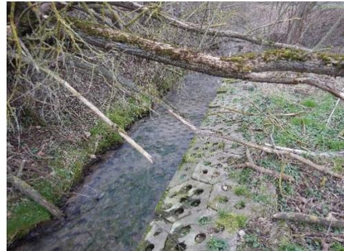
Abb. 10: massiver Verbau mit Rasengitter
