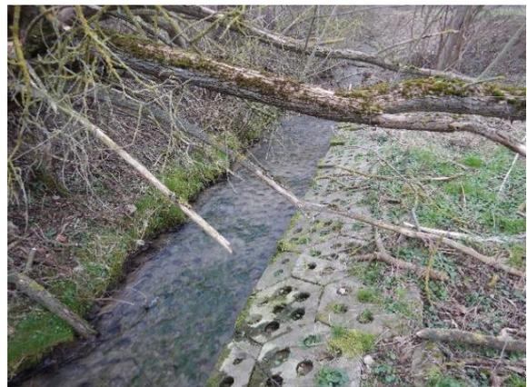
Abb. 4: Verbau und Sohlbefestigung mit Rasengitter.
