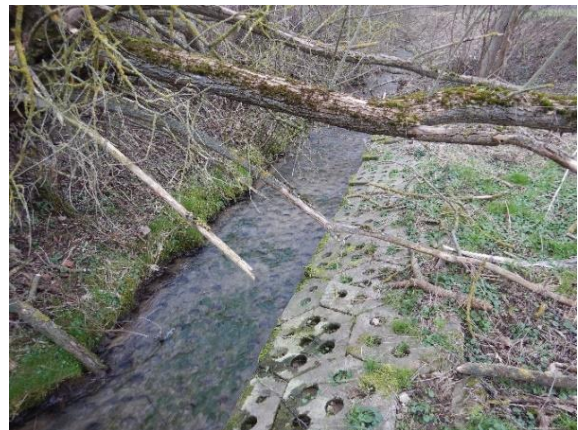
Abb. 4: Verbau und Sohlbefestigung mit Rasengitter.
