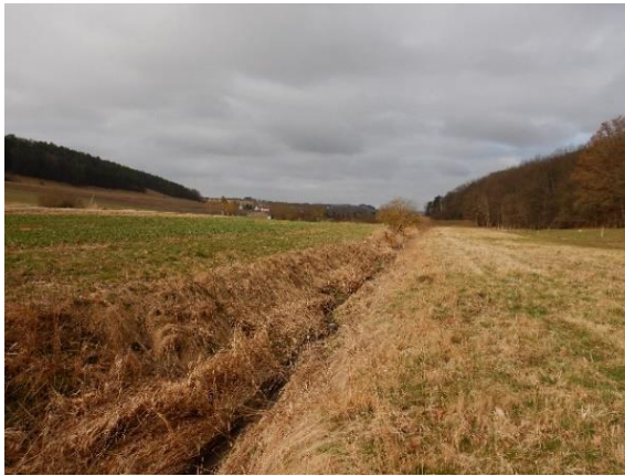
Abb. 1: Trapezprofil und fehlender Bewuchs (Gehölze).
