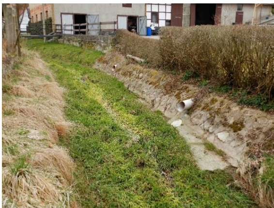
Abb. 5: Massiver Verbau in der Ortslage Krakendorf.
