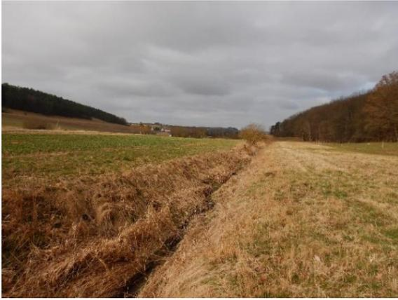
Abb. 11: Trapezprofil und fehlender Bewuchs (Gehölze).
