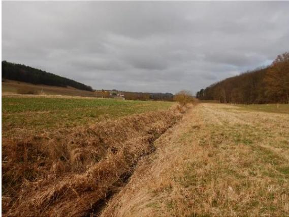
Abb. 4: Trapezprofil und fehlender Bewuchs (Gehölze).
