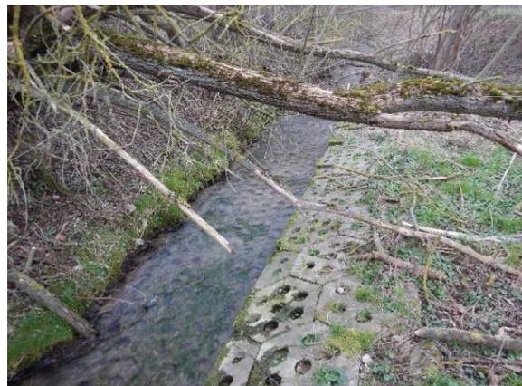
Abb. 7: Verbau, Sohlbefestigung.
