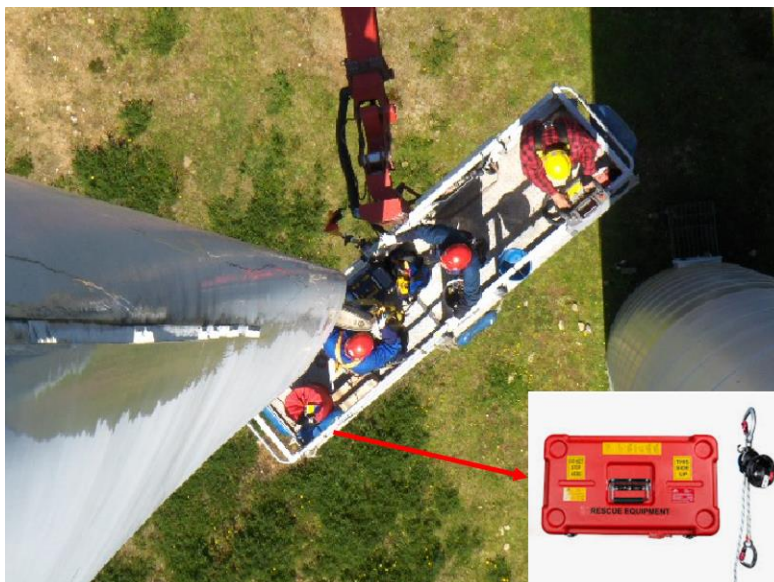
Abbildung 10-1: Beispiel für einen Notabstieg an einem Mannkorb
