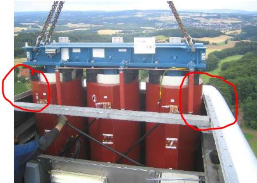
Abbildung 18-1: Führen des Transformators in das Maschinenhaus
