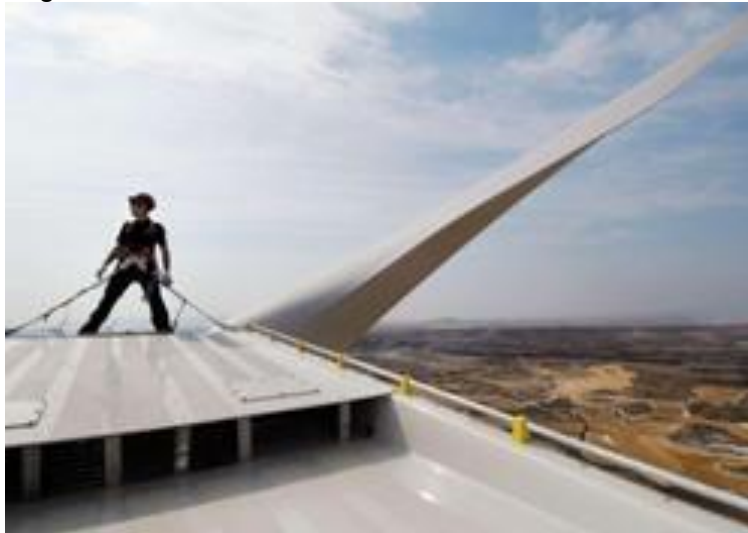
Abbildung 10-2: Arbeiten auf dem Maschinenhaus
