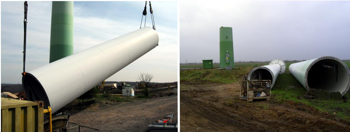
Abb. 16: Stahlsektion beim Ablegen (links), demontierte Stahlsektionen (rechts)
