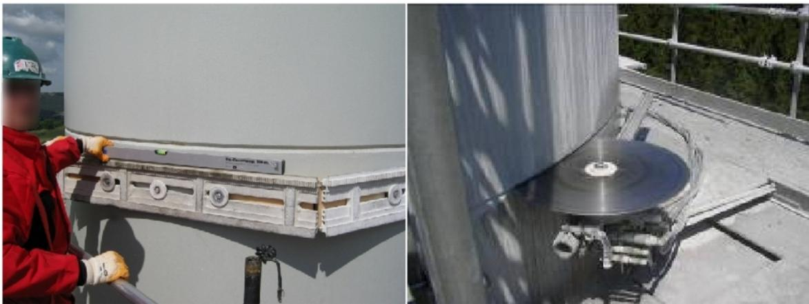
**Abb. 9: Führungsschiene für die Betonwandsäge am Segment verschraubt (links), Betonwandsäge (rechts)**
