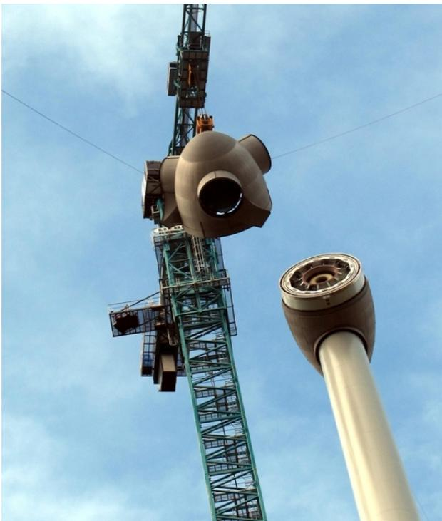
**Abb. 4: Rotorkopf angeschlagen**
