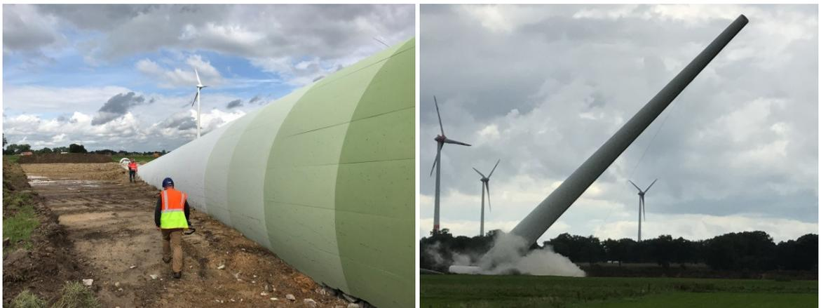
**Abb. 13: Umgelegter Turm (links), kontrolliertes Fallen des Turms (rechts)**
