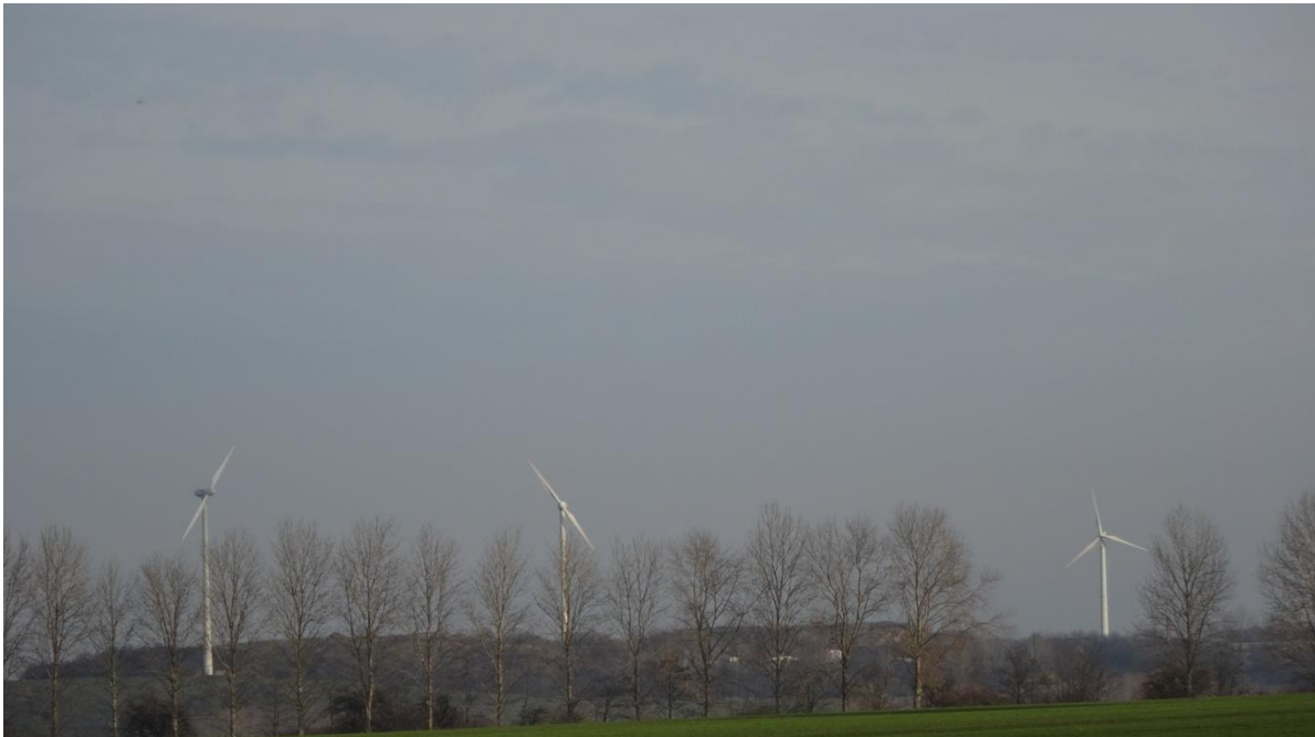
Abbildung 4-4: Blick von Stobra auf den Bestands-Windpark Wormstedt
