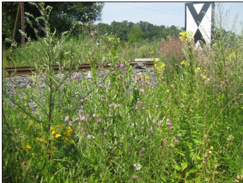
Abbildung 21: Bahndammvegetation (Foto: A. Helmholz, 17.07.2013)
