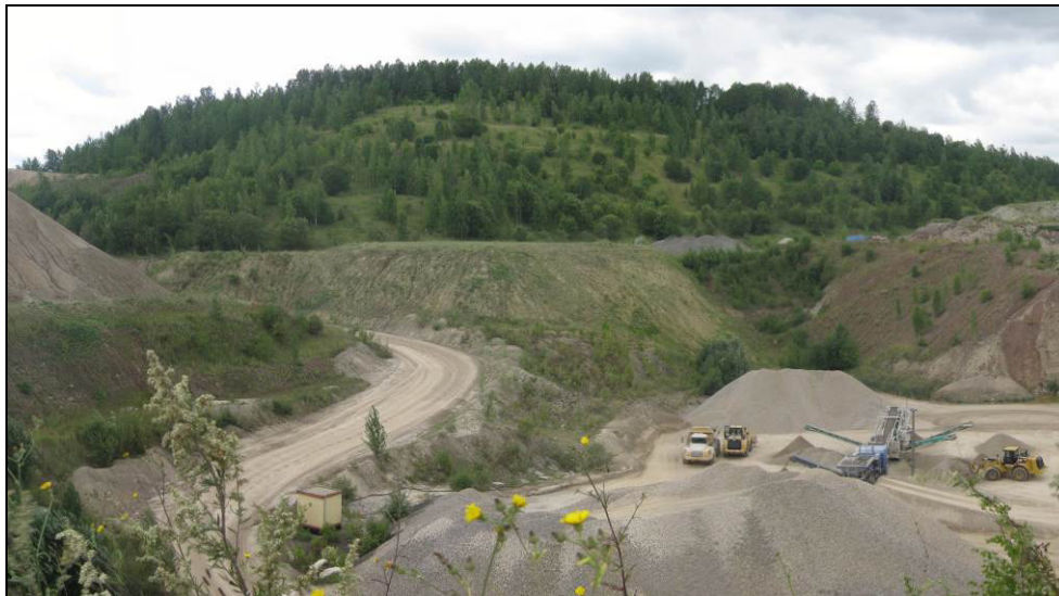
Abbildung 6: die sich bereits begrünenden Bermen des Läuseberges (Südkippe), rechts im Bild: mobile Aufbereitungsanlage (Foto: A. Helmholz, 31.07.2013)
