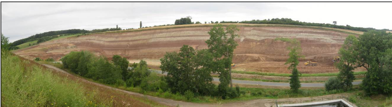
Abbildung 3: Blick auf das Nordfeld II (Foto: A. Helmholz, 31.07.2013)
