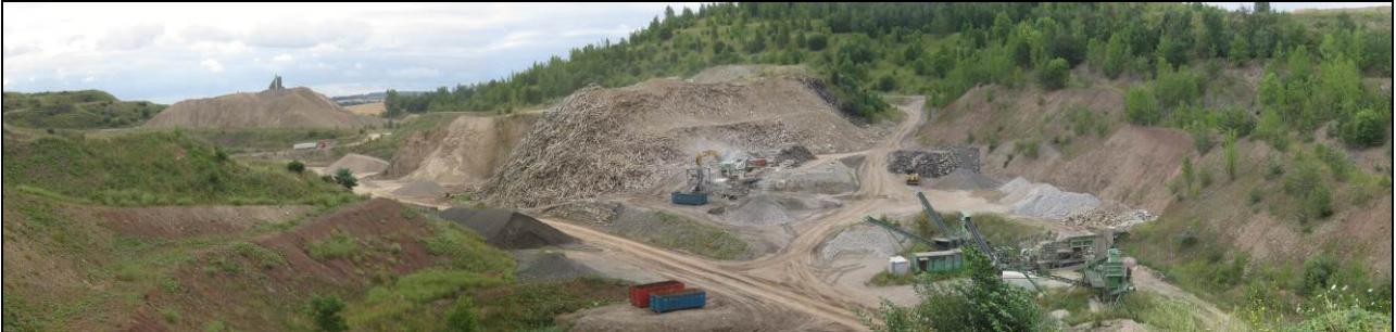
Abbildung 5: Spontanvegetation auf dem Betriebsgelände. links im Bild: lückige Vegetation auf Betriebsböschungen. zentral im Bild: Brecheranlage, rechts im Bild: Pioniergehölze (Foto: A. Helmholz, 31.07.2013)
