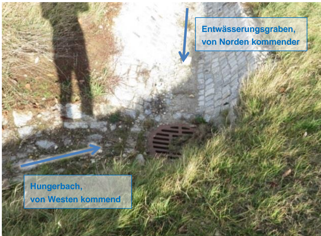
Abbildung 3: Kanaleinlauf in Oberdorf (Quelle: BCE Erfurt)
