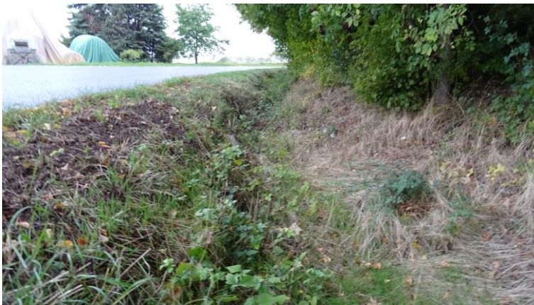
Abbildung 4: Hecke im Bereich „Nördlicher Graben“ – bestehendes Grabenprofil
