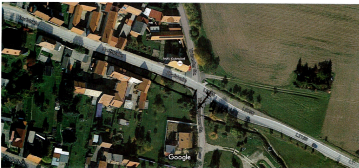
Abbildung 60: Entlastungskanal durch die L2155 in Verbindung mit der Absenkung der Landesstraße im Unterdorf
