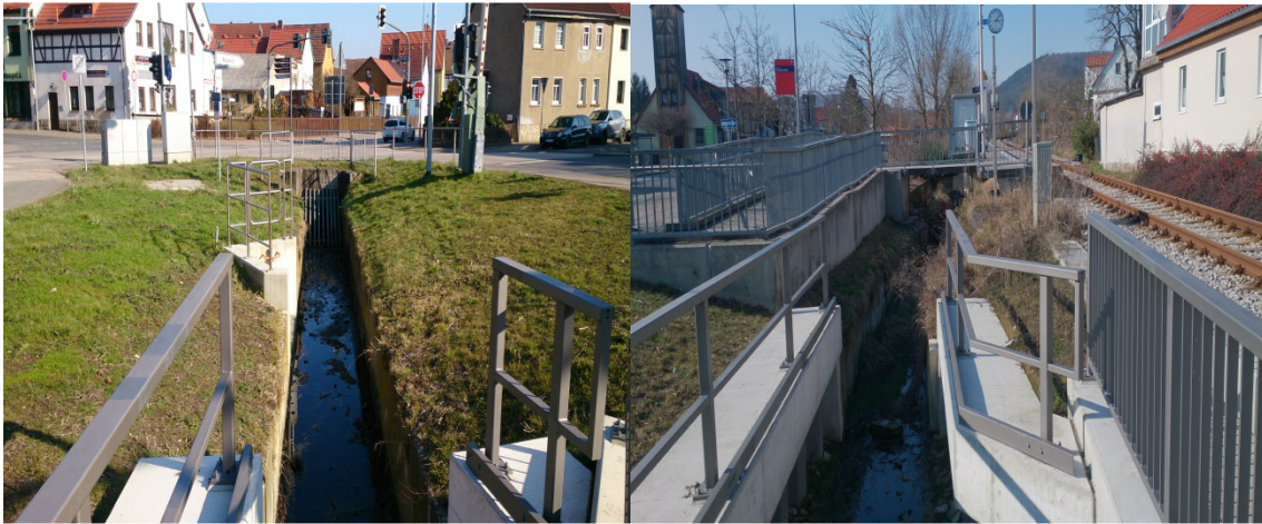
Abbildung 17: Grabenausbau/-befestigung in Bad Berka
