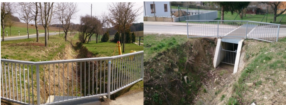
Abbildung 6: Gutendorf (Unterdorf) – Beginn offener Graben (li: Blick Grabenverlauf in Richtung KA; re: Ansicht Entwässerungsbauwerk „Tiefengrubener Straße“)
