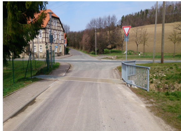
Abbildung 72: Kasten-Durchlass mit Gitterrostabdeckung „Tiefengrubener Straße“
