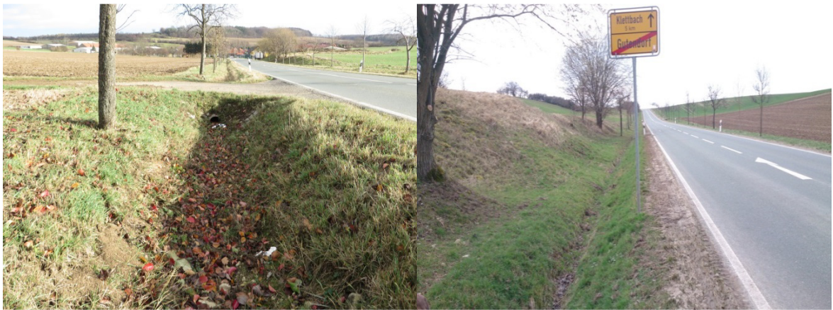
Abbildung 2: Oberhalb OL Gutendorf (li: L 2155 - Blick in Richtung OL; re: L2155 - Blick Ortsausgang in Richtung Meckfeld/Klettbach)
