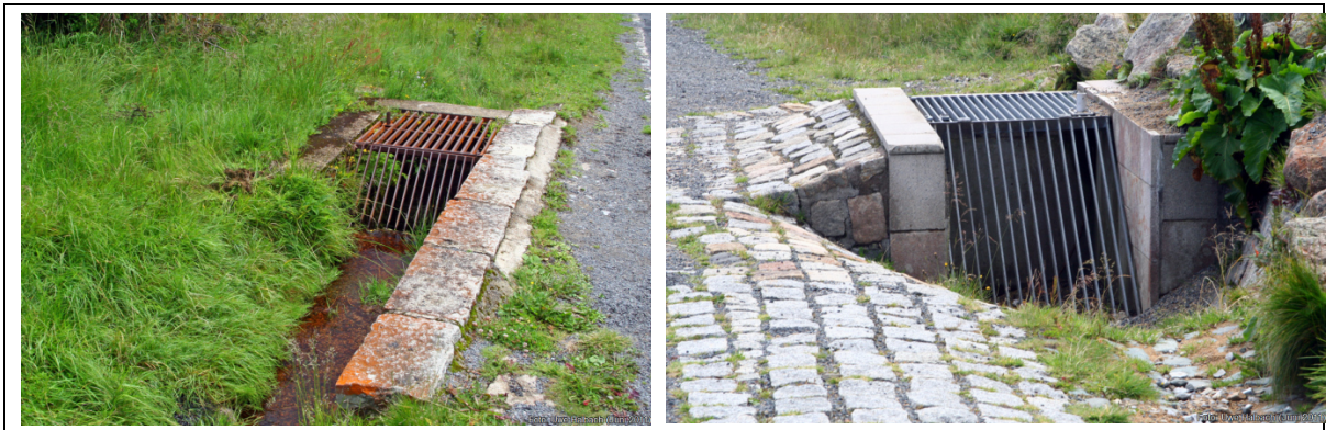
Abbildung 56: Beispiel für robuste Einlaufbauwerke mit Handrechen ohne Geröll- und Sandfang
