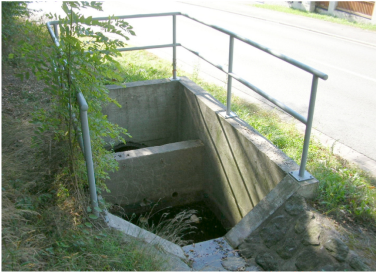
Abbildung 74: Beispiel Sedimentfang vor Rohrdurchlass für kleine Gräben
