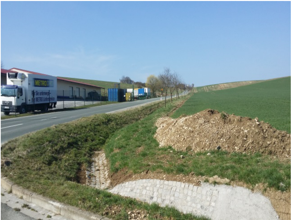
Abbildung 41: Ausgebaggerte Geröllmassen - obere Ortseinfahrt Gutendorf
