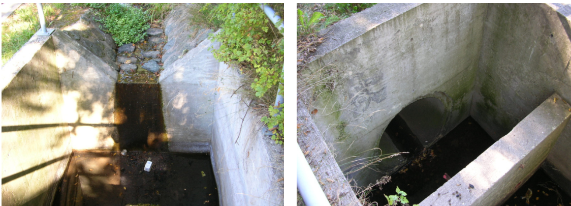
Abbildung 75: li: Zulauf Sedimentfang, re: Sedimentfang mit Ablauf Rohrdurchlass
