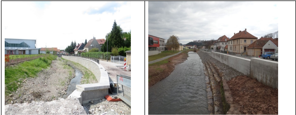
Abbildung 61: Beispiele - li: Ufermauer als HWS-Mauer in Mihla, Thüringen (Quelle: BCE Erfurt); re: HW-Schutzwand Bad Neustadt a.d. Saale, Bayern (Quelle: Wasserwirtschaftsamt Bad Kissingen)
