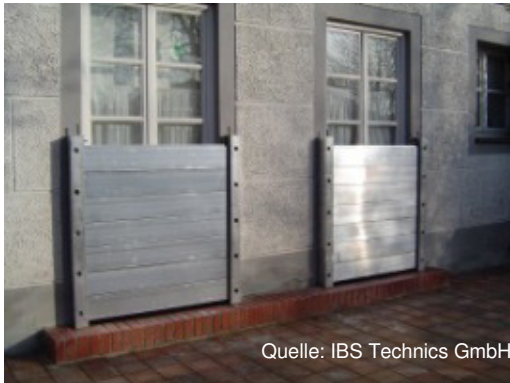
Abbildung 62: Bsp. mobile Objektschutzmaßnahmen zur Sicherung von Öffnungen, Türen, Fenstern und Zuwegungen
