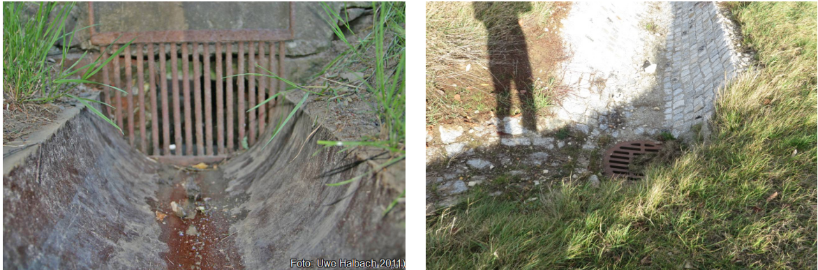
Abbildung 54: Beispiele für ungeeignete Einlaufbauwerke
