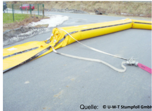
Abbildung 62: Bsp. mobile Objektschutzmaßnahmen zur Sicherung von Öffnungen, Türen, Fenstern und Zuwegungen
