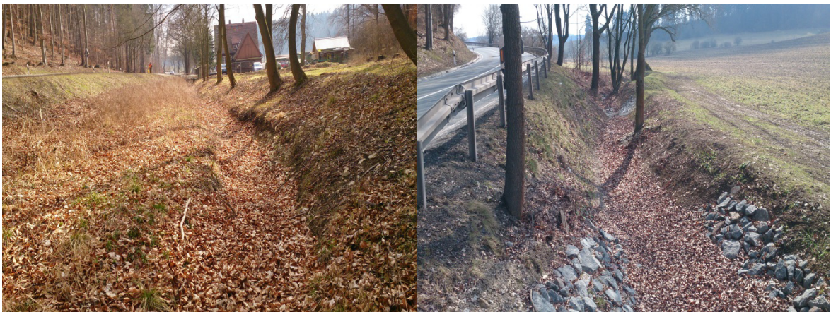
Abbildung 8: Offener Gewässergraben – Blick stromab (li: oberhalb Forsthaus; re: unterhalb Forsthaus)
