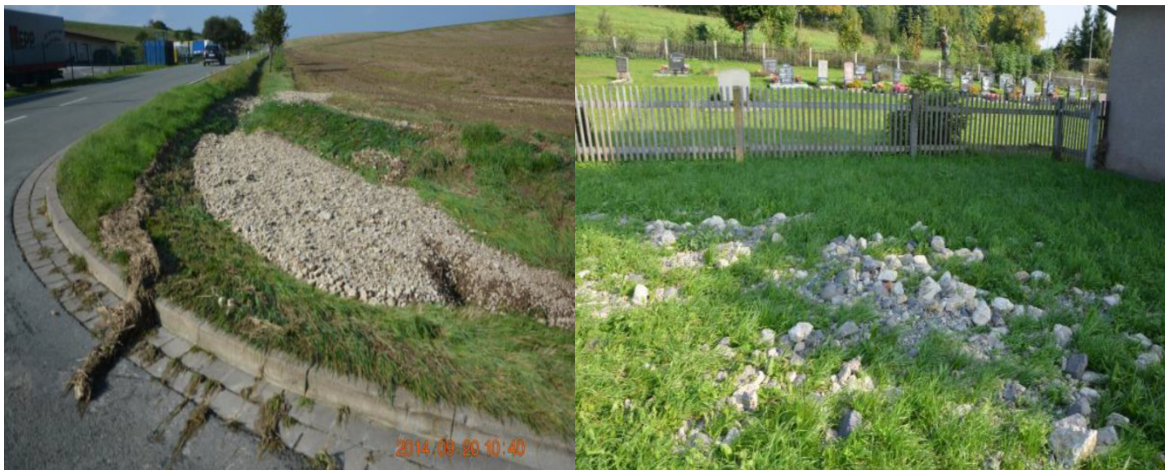
Abbildung 42: Nach dem HW 19.09.14 in Gutendorf – li: verfüllter Graben mit Geröll re: Geröllablagerungen am Friedhof (Quelle Fotos: HWSK Gutendorf [9])
