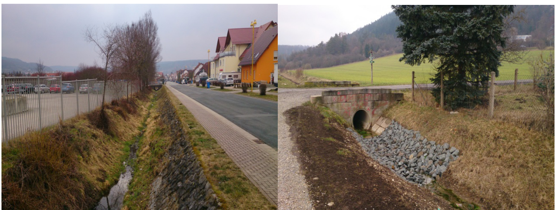
Abbildung 19: li: Bad Berka – Gewässerausbau mit Böschungsbefestigung; re: oberhalb Bad Berka – Grabenbefestigung mit Betonplatten und grober Steinschüttung
