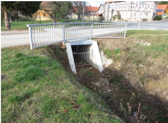
Abbildung 72: Kasten-Durchlass mit Gitterrostabdeckung „Tiefengrubener Straße“
