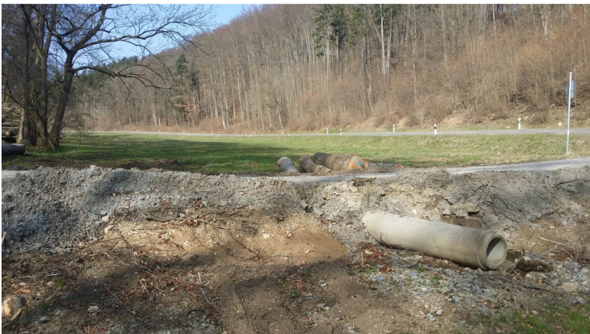
Abbildung 49: Talsohlenquerung mit Rohrdrossel
