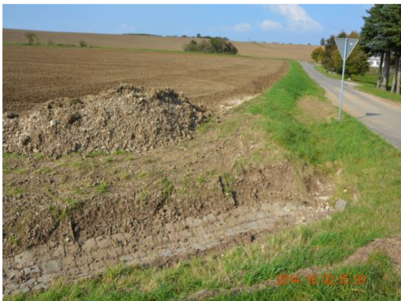
Foto 014: Bereich Graben 1: westlich Kulturhaus, Schutt wieder ausgebaggert; im Bildhintergrund Graben noch vom letzten Jahr verfüllt
