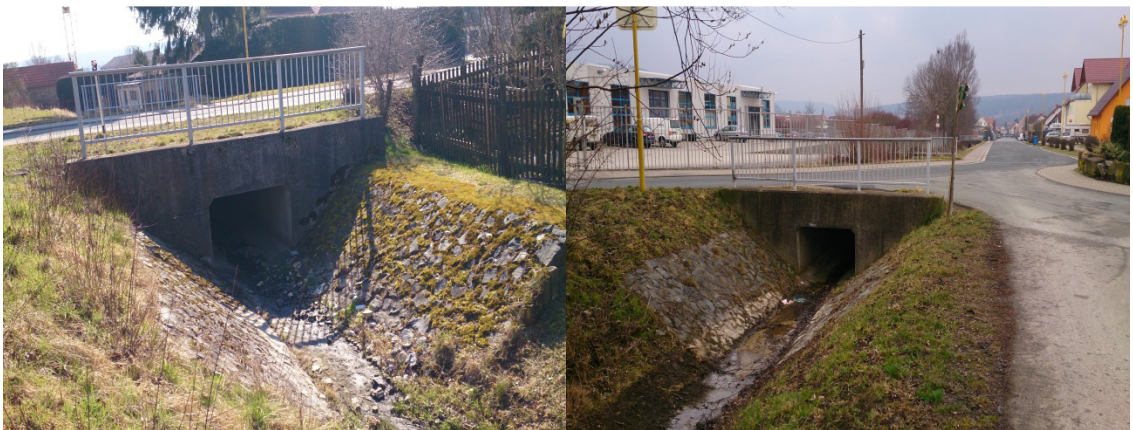
Abbildung 18: Bad Berka: Sohlen- und Böschungsbefestigung mit Wasserbaupflaster im Bauwerksbereich
