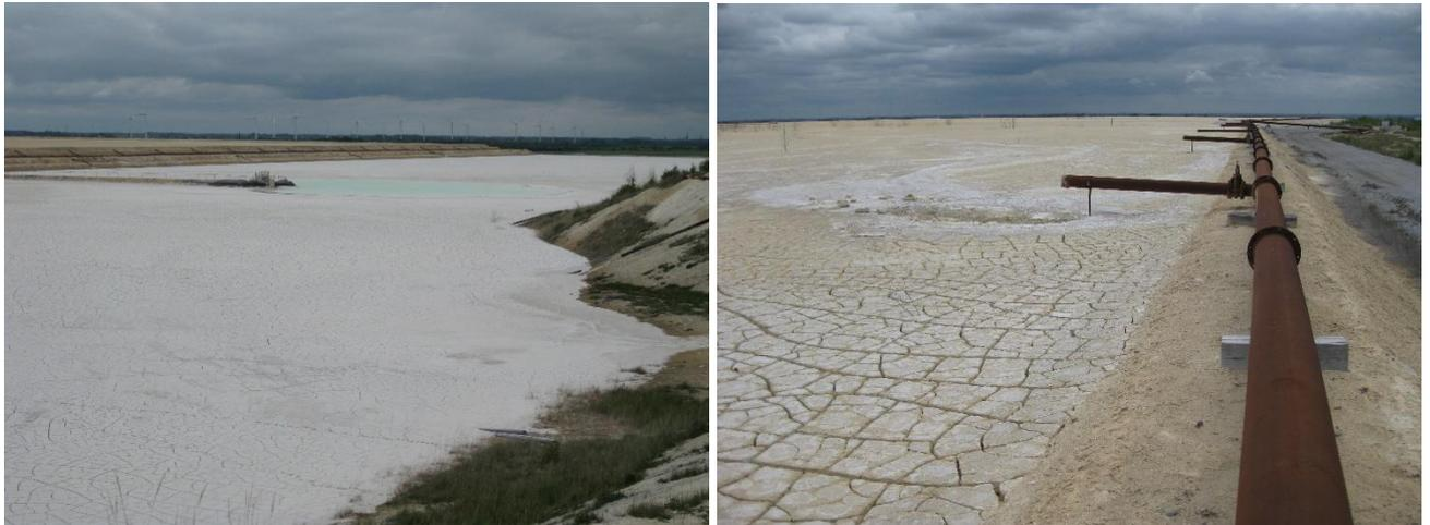
Abbildung 3-1: Blick in aktiven Kalkteich während Bepflanzung und Konsolidierung / Rohrleitungsnetz zur Bepflanzung
