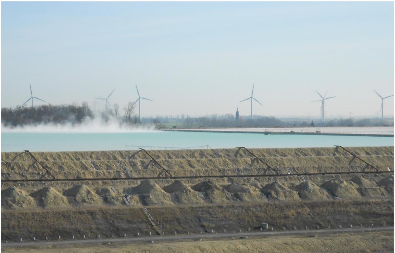
Abbildung 5-1: Kalkteich 18 bei aktiver Einspülung unter kalten Umgebungstemperaturen
