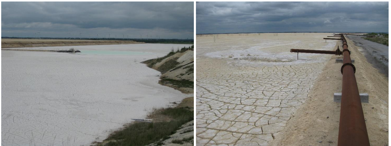
Abbildung 3-2: Blick in einen aktiven Kalkteich während / nach der Bespülung sowie Rohrleitungsnetz zur Bespülung
