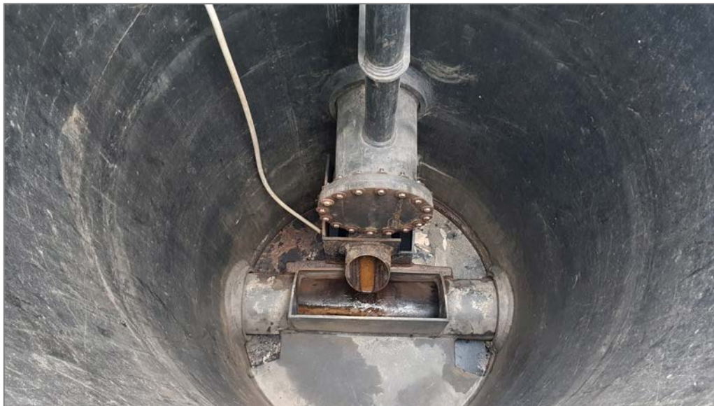
Abbildung 10: Deponie Lindenberg, Ausbau Sickerwassersammelschacht (hier S11, Aufnahme von August 2021)
