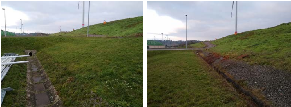
Abbildung 13: Deponie Lindenberg, Fotoaufnahmen unterer Randgraben (links) und oberer Randgraben (rechts)
