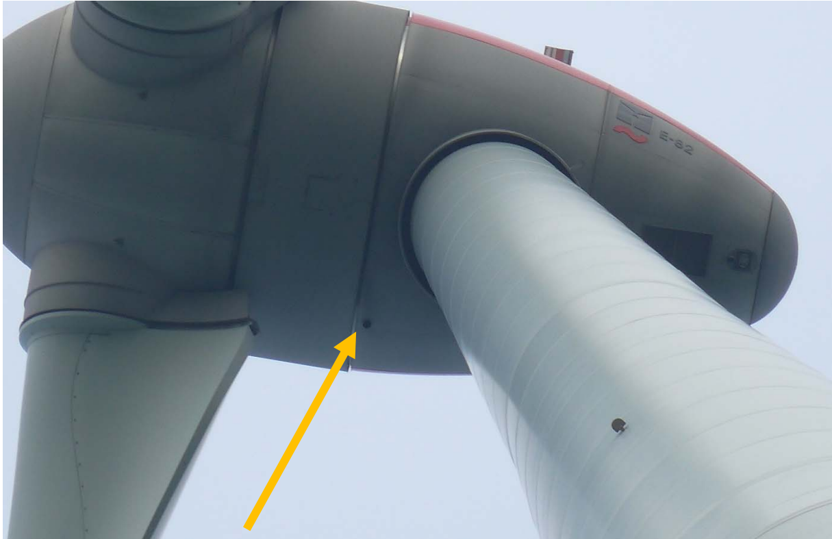
Abbildung 10: Außenmikrofon für das Gondelmonitoring (Pfeil).
