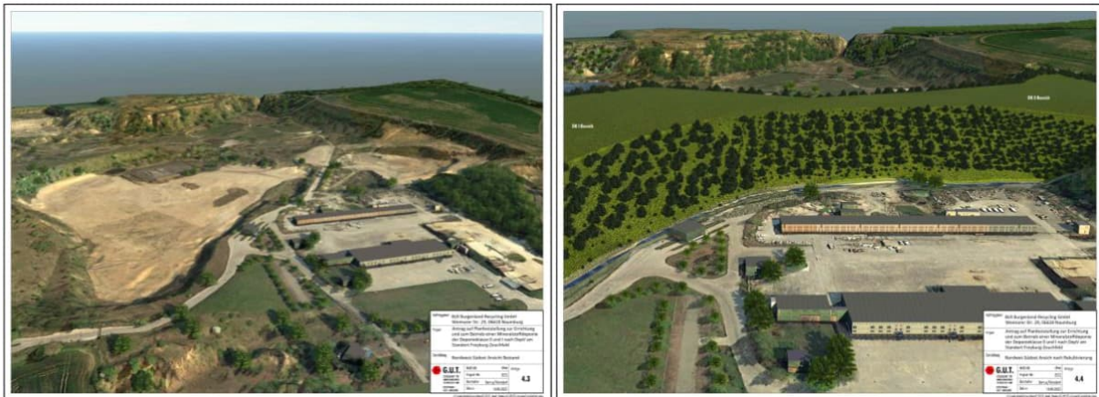
Abbildung 4: Nordwest-Südost Ansicht vor (links) und nach (rechts) der Errichtung der Deponie (Anlage 4.3 und 4.4)
