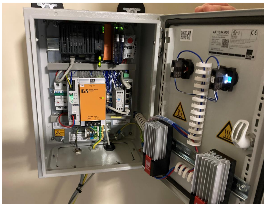
Abbildung 11-2: Innenansicht SMU Modul des Schattenwurfschutzsystem
