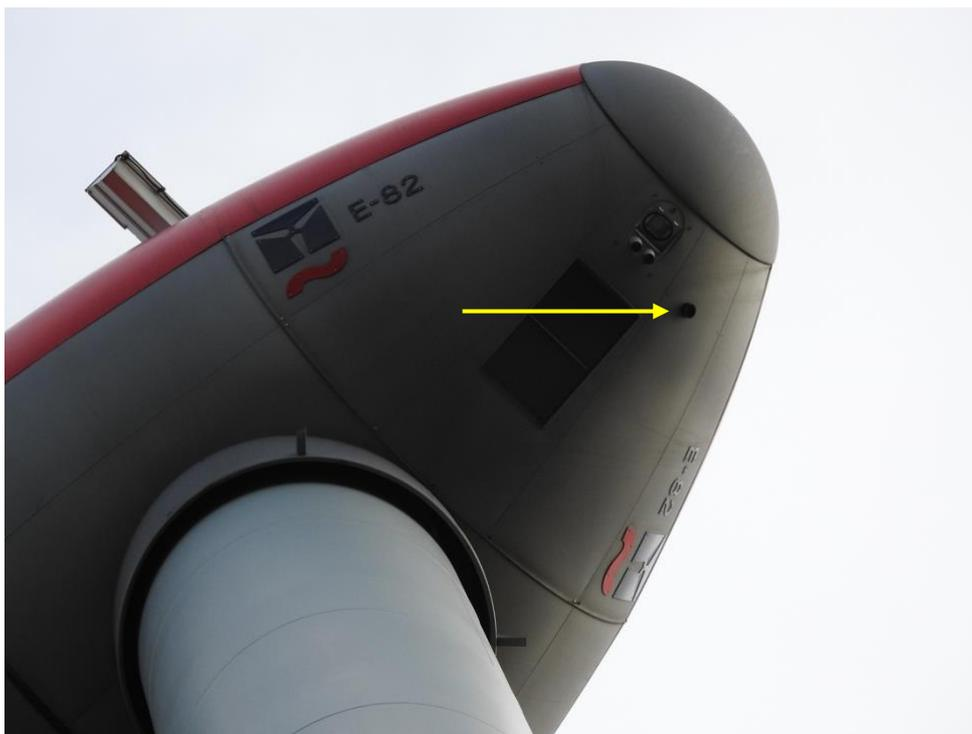
Abb. 3: Öffnung für Batcorder-Mikrofon in WKA (im Bild ist nicht der untersuchte Anlagentyp dargestellt)
