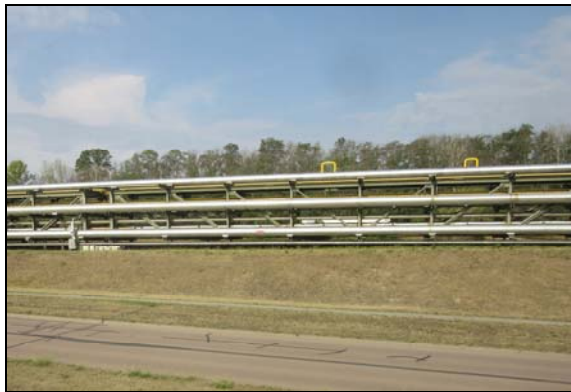
Abbildung 3: Stark geschädigte Grasnarbe in den Böschungsbereichen
