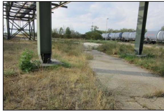
Abbildung 4: Ruderalflur unter Rohrbrücke
