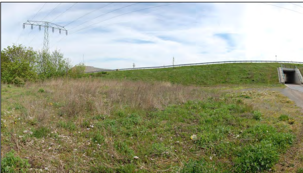
Abbildung 63: Blick von Kajendorfstraße Richtung Nordosten auf Damm der B 180 in Richtung geplanter Deponie (im linken Bildbereich sind Reste der Abraumhalde sichtbar)
