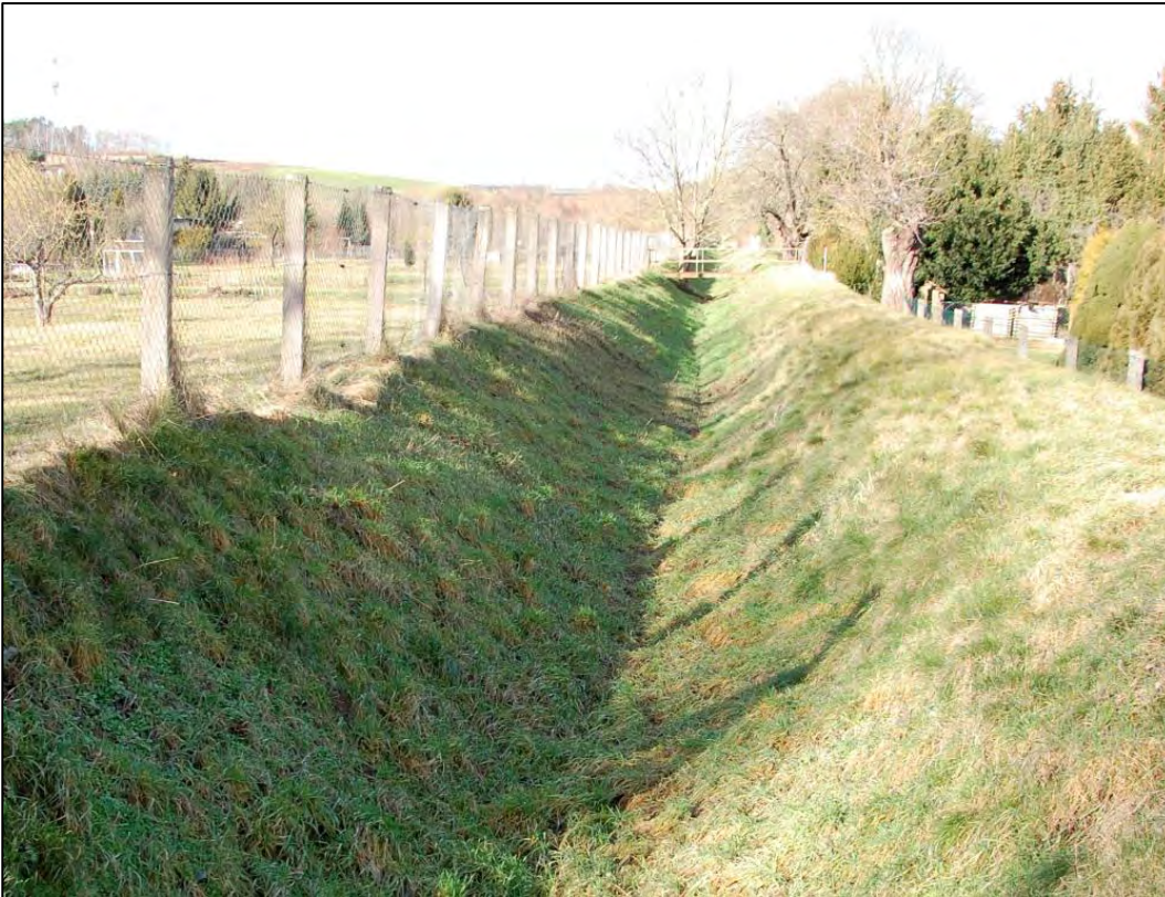
Abbildung 25: Sonstiger Graben, nicht wasserführend, trotz Hochwasser (Januar 2018)
