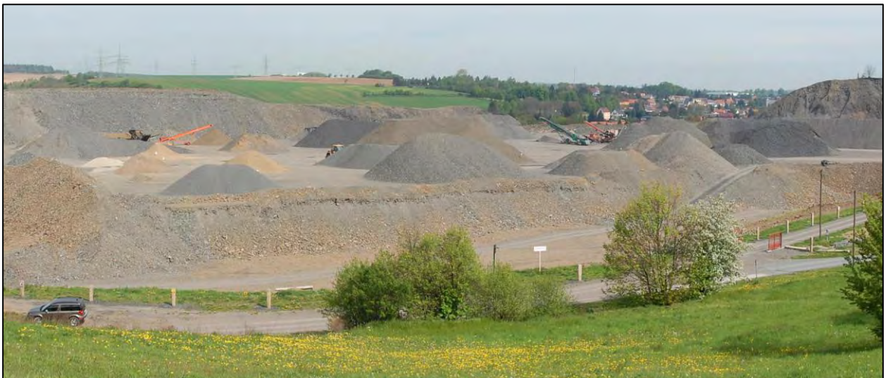
Abbildung 54: Blick Richtung Norden auf den genutzten Haldenkörper (Bildmitte)
