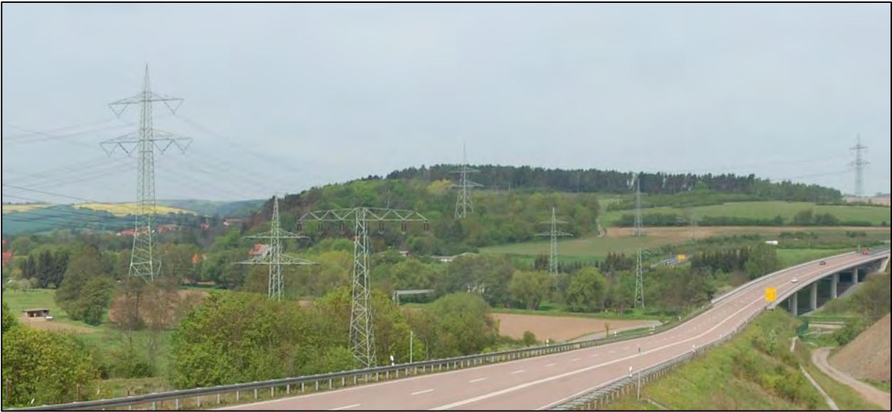
Abbildung 49: Blick Richtung Nordwest - technogene Belastung im Nahbereich der geplanten Deponie, durch Bundesstraße B 180 und Hochspannungsleitungen
