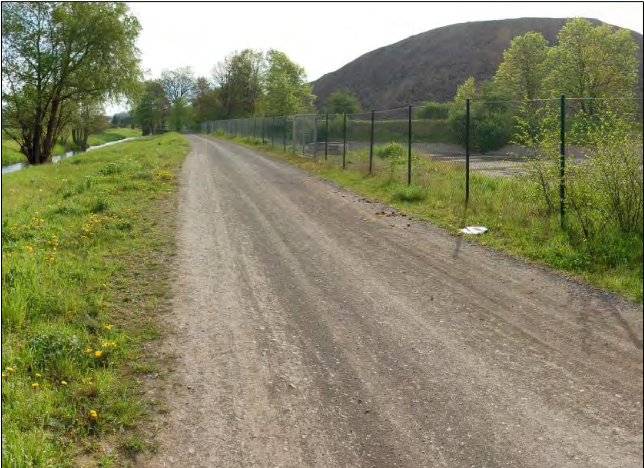
Abbildung 39: Befestigter Weg (Kajendorfstraße zwischen Wipper und geplanter Deponie, Richtung Großörner)
