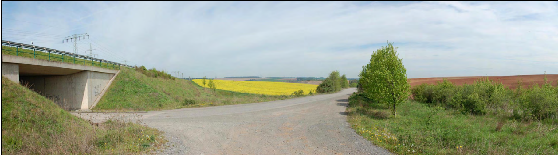
Abbildung 70: Blick vom Zufahrtsbereich (Unterführung B 180 – linke Bildhälfte) Richtung Eingang Haldenfläche
