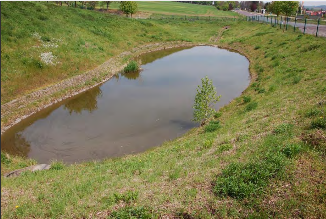
Abbildung 41: Retentionsbecken an der Bundesstraße B 86
