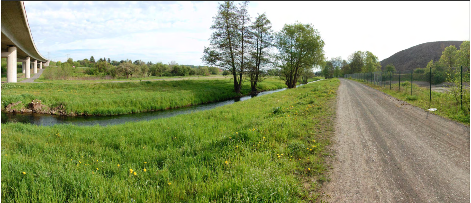
Abbildung 66: Blick vom, parallel zur Wipper verlaufenden, Weg „Am Wehr“ in Richtung Nordost nach Großörner (links – Haldenkörper)
