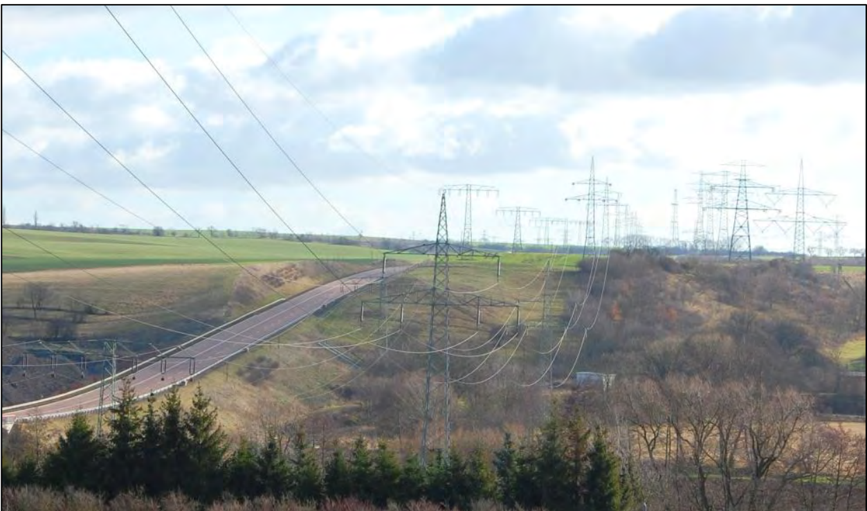
Abbildung 50: Blick Richtung Südost – technogene Belastung durch B 180 und kV- Leistungen
