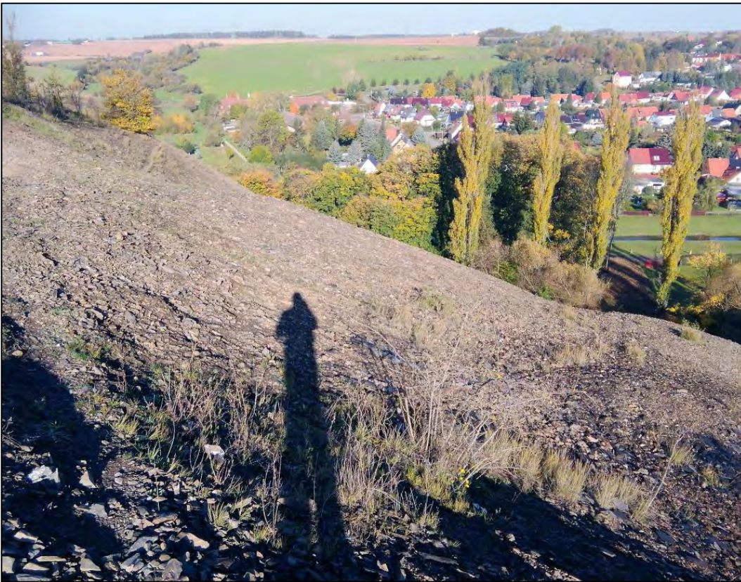
Abbildung 44: Bergbauabraumfläche im Nordosten der geplanten Deponie
