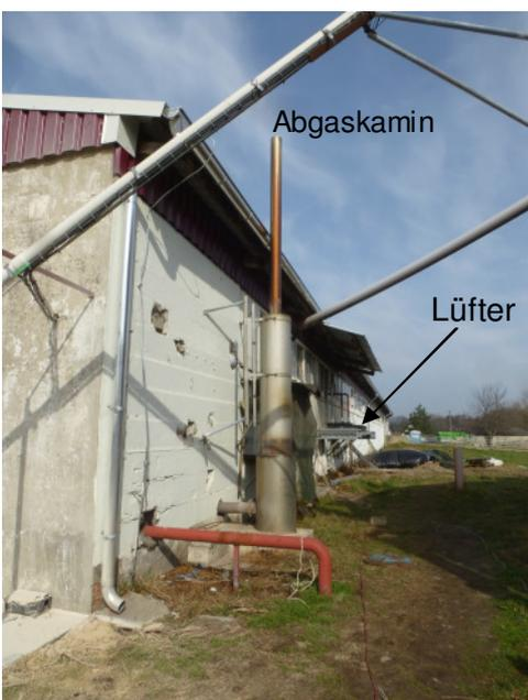
**Bild 3:** Abgaskamin des BHKW am Stall 9 mit Schalldämpfern und Lüfter
