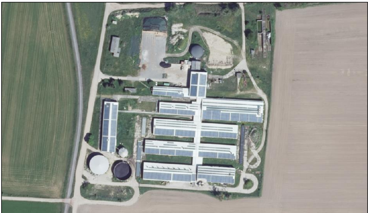
Abbildung 3: Luftbild der bestehenden Schweinezuchtanlage in Lübars
