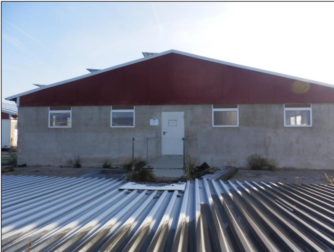
Abbildung 2: Vorhabensfläche für geplante Abluftreinigungsanlage – Ansicht 2
