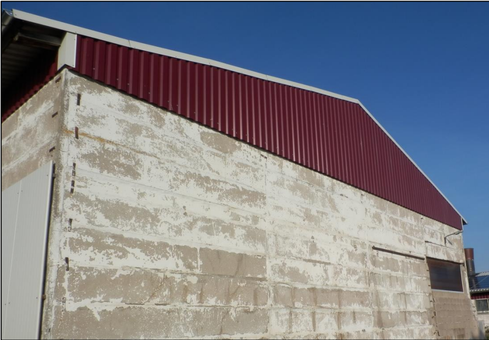
Abbildung 2: Vorhabensfläche für geplante Abluftreinigungsanlage – Ansicht 1
