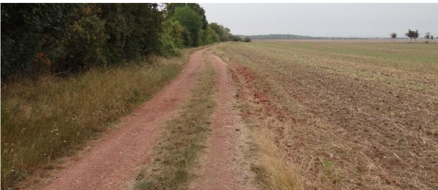
Abbildung 18: Überwiegend unbefestigter Weg nördlich der Bahntrasse (nur teils leichte Schotterung vorhanden)
