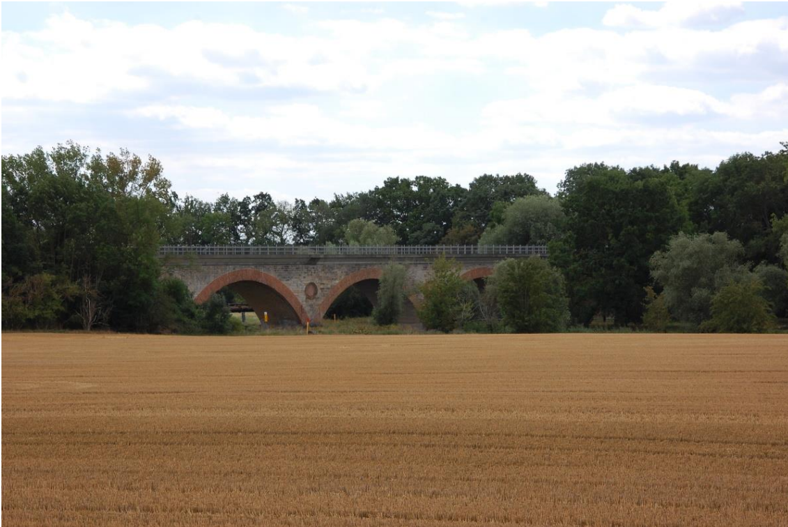
Abbildung 32: Markantes Brückenbauwerk über die Bode bei Hohenerxleben
