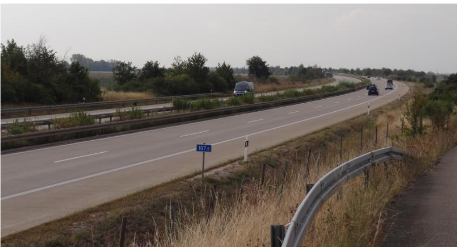
Abbildung 21: Autobahn A14 im östlichen UG
