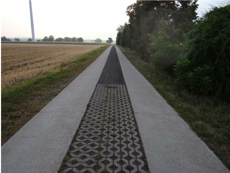
Abbildung 19: Befestigter Weg (Betonplatten mit geschottertem Mittelstreifen) befestigter Bankettbereich
