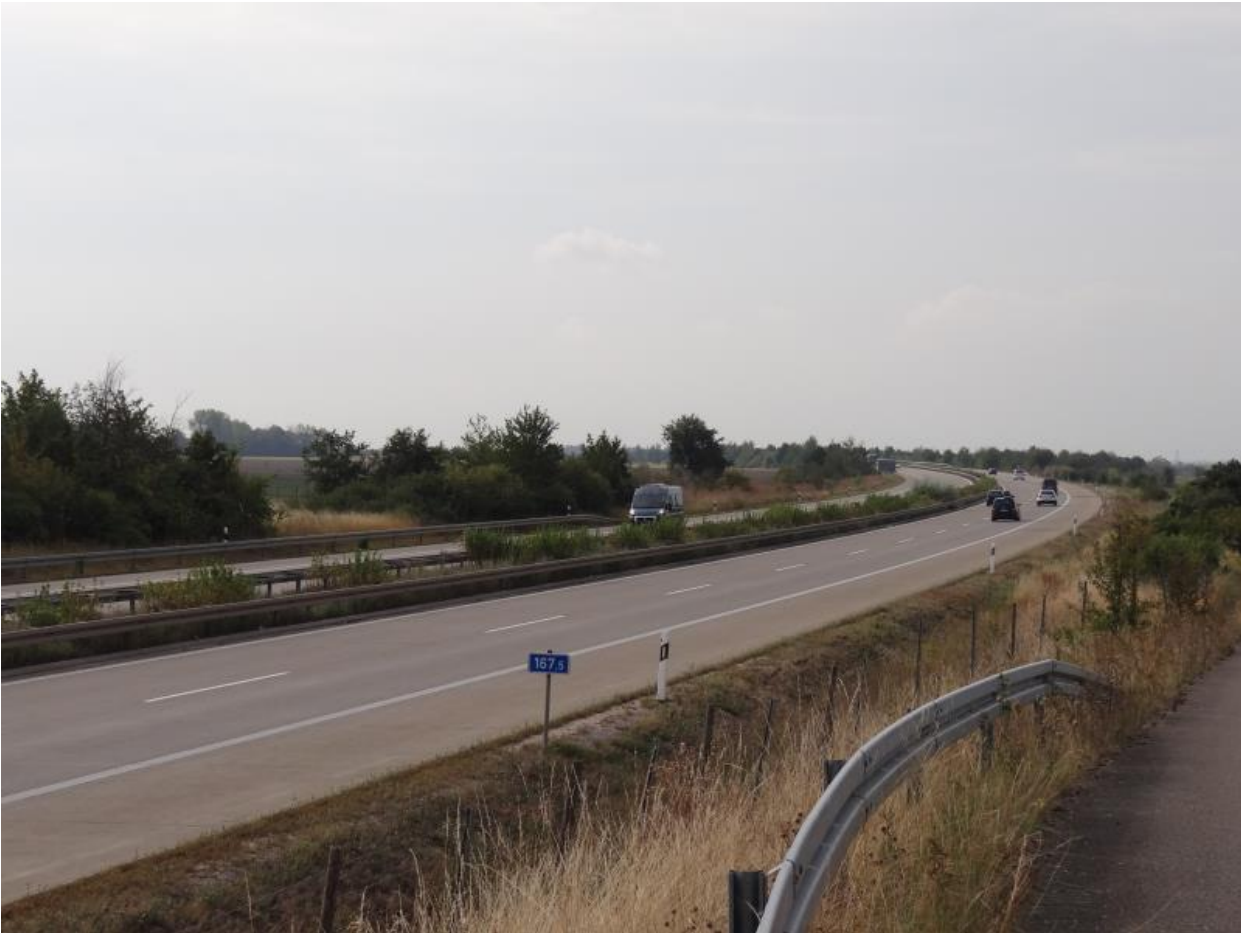
Abbildung 15: Autobahn A14 im östlichen UG
