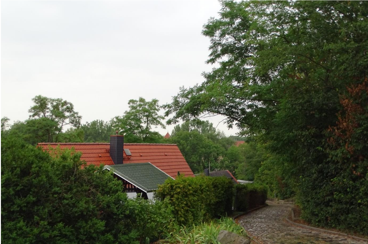
Abb. 38: Sicht von der Plattform nordwestlich der Kirche St. Gertrud in Richtung des geplanten WP Brumby.
