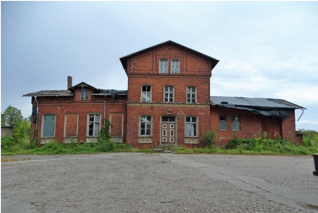
Abb. 6: Bahnhof Neugattersleben – Frontansicht (eigene Aufnahme).
