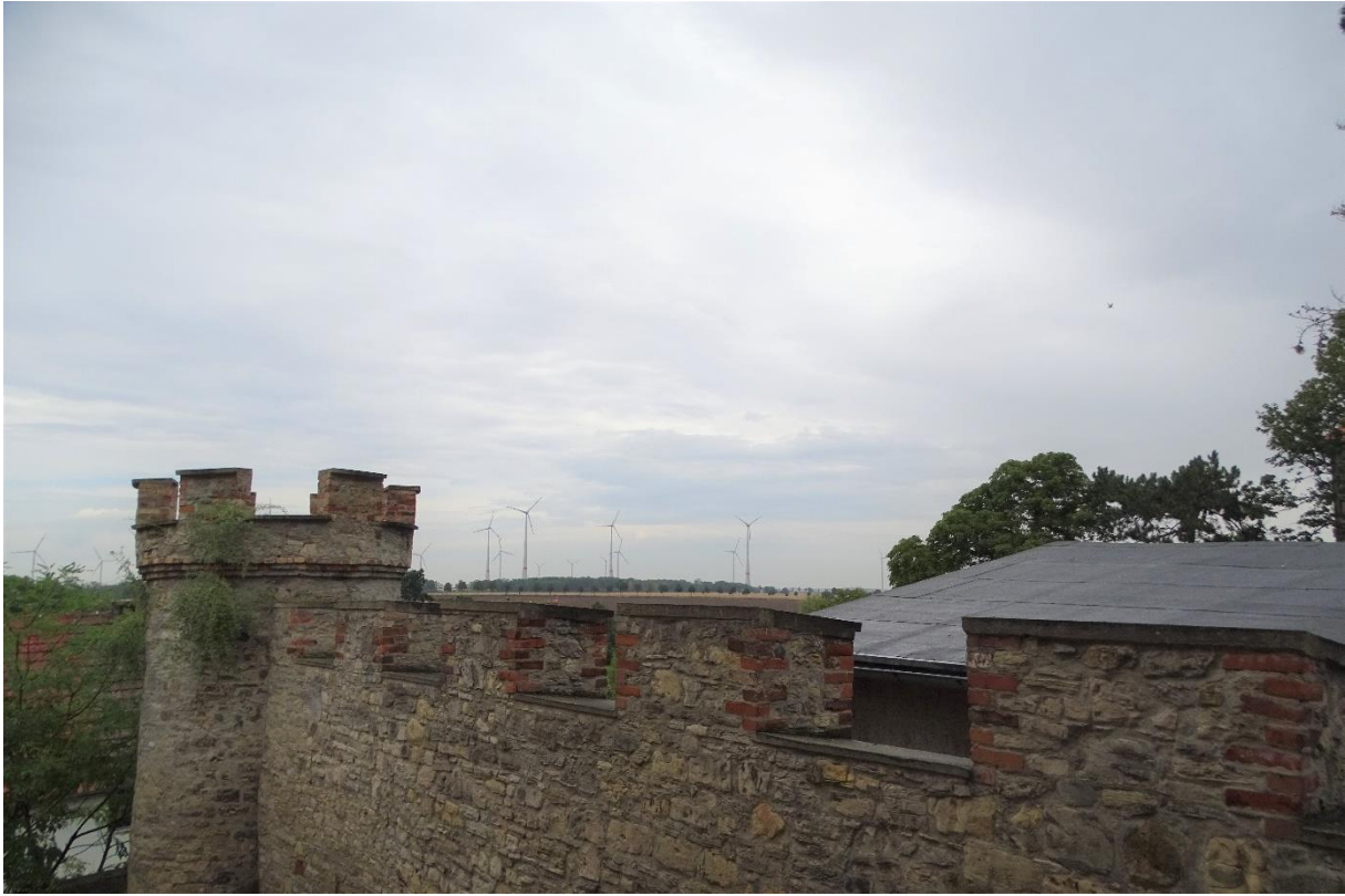
Abb. 17: Sicht von der Plattform östlich der Kirche St. Petri in Richtung WP Brumby.
