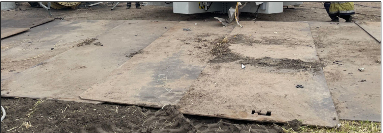
Abbildung 4 exemplarische Darstellung Stahlplattenlage für Brennschneidarbeiten
