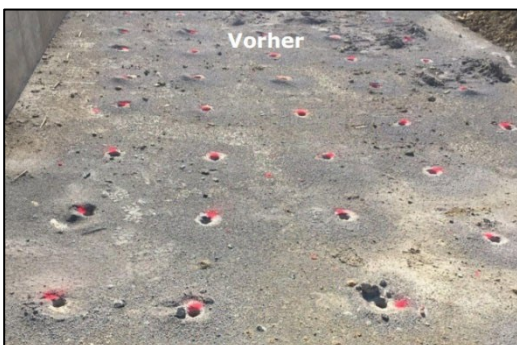
Abbildung: Vergleich vorher und nachher Lockersprengung
