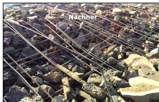
Abbildung: Vergleich vorher und nachher Lockersprengung
