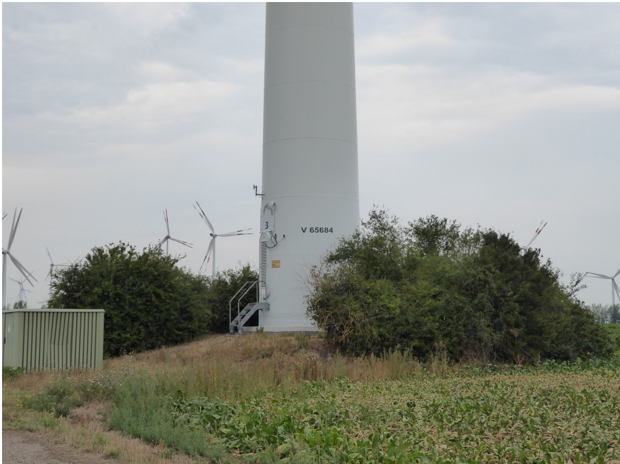
Abbildung 14: Buschwerk unter einer der drei rückzubauenden WEA.
