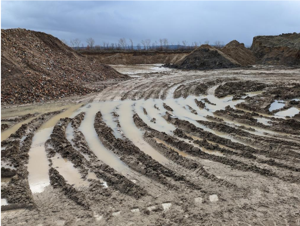
Wassergefüllte Fahrspuren im zentralen Bereich der geplanten Deponiefläche (Foto: Dr. Thomas Kühn)
