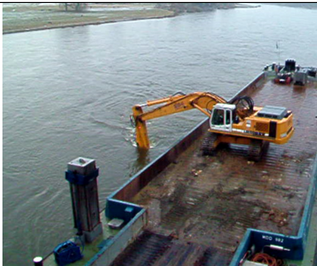
Foto 29: Aufrauen des Gewässerbodens von oberstrom nach unterstrom längs des Schubverbandes.
