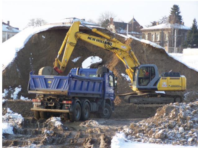
Foto 16: Zwischenlagerfläche für Massen. Nach erfolgtem Einschwimmen des Brückenbogens erfolgte die Rückverfüllung der zwischengelagerten Massen. Hierzu wurden die zwischengelagerten Massen auf LKW geladen und zur Umladestelle am Elbeufer transportiert.
