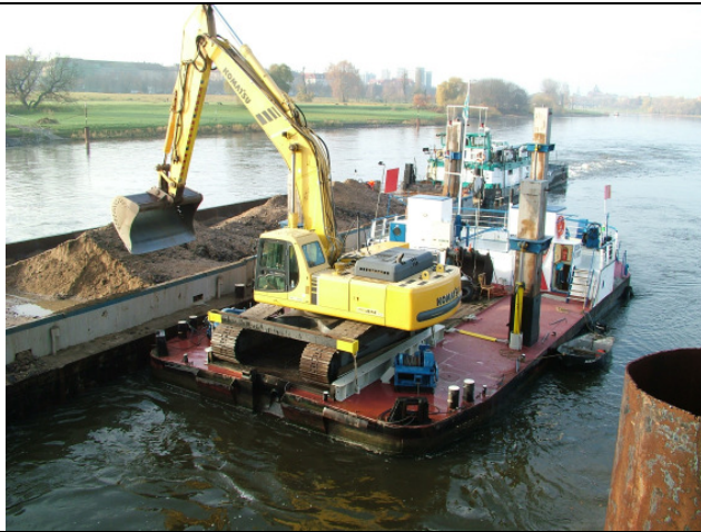
Foto 1: Technik zum Auskiesen der Elbe. Zum Einsatz kamen ein eigenständig steuerbares Ponton mit fixierbaren Hydraulikbagger zum Aushub der Massen sowie ein Schubverband zur Aufnahme und zum Transport der ausgehobenen Massen.
