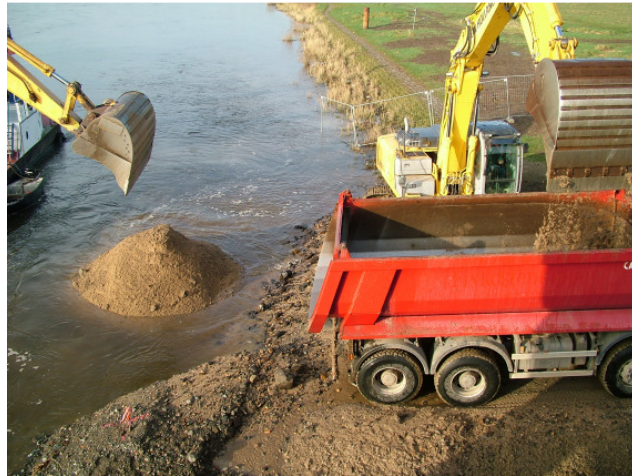
Foto 13: Umladevorgang vom Schubverband auf LKW. Hierzu steuerte der mit dem Bagger beladene Ponton soweit möglich, d.h. in Abhängigkeit von Wassertiefe der Elbe und Tiefgang des Pontons, an das Ufer. An den Ponton wiederum machte seitlich der Schubverband fest, sodass dieser mit dem auf dem Ponton befindlichen Bagger entladen werden konnte (Baggerschaufel links im Bild).
