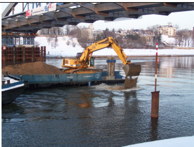
Foto 23: Einbau der Massen mittels Hydraulikbagger.
