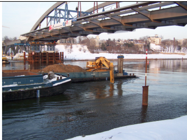
Foto 18: Aufräumen der Elbesohle linkselbisch vor Wiedereinbau der Massen mittels Hydraulikbagger.
