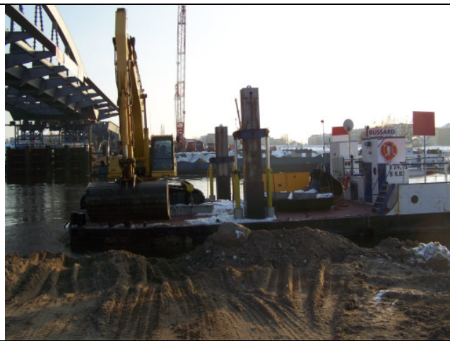
Foto 17: Am Elbeufer erfolgte an gleicher Stelle wie bei der Ausbaggerung das Umladen der Massen vom LKW auf den Schubverband oder die Klappschute. Der Schubverband war mit einem zusätzlichen Hydraulikbagger ausgestattet, der das Aufräumen, den Wiedereinbau und das Planieren an der Sohle übernahm.
