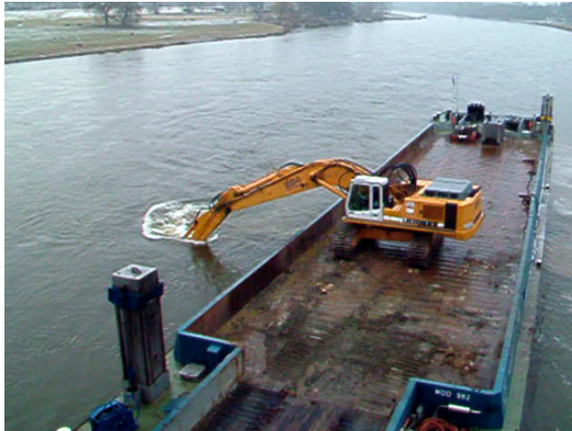
Foto 28: Aufrauen des Gewässerbodens von oberstrom nach unterstrom längs des Schubverbandes.
