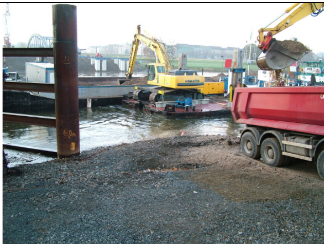
Foto 12: Umladevorgang vom Schubverband auf LKW, um die Massen an Land außerhalb des Hauptabflussgebietes der Elbe zwischenzulagern. Die Massen wurden mittels Bagger vom Schubverband aufgenommen und im Uferbereich abgesetzt, um dort von dem an Land stehenden Bagger aufgenommen werden zu können, der folglich die Verladung auf LKW vornahm. Der Umladevorgang erfolgte innerhalb des Baufeldes Unterstrom des Anprallschutzes (links im Bild) der Hilfspfeiler für den Brückenbogen.
