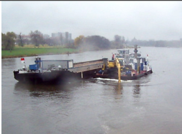
Foto 2: Aufräumen der Gewässersohle nach Positionierung des Baggerpontons. Das Aufräumen erfolgte jeweils im Greiferradius des Baggers bevor der Aushub in diesem Bereich erfolgte. Zum Aufräumen wurde die Baggerschaufel nahe der Gewässersohle entlang gezogen, sodass die obere Schicht durchkämmt bzw. durch den Sog der Baggerschaufel aufgewühlt wurde. Damit wurde ein Abdriften für in der Gewässersohle vorkommende Arten gewährleistet.
