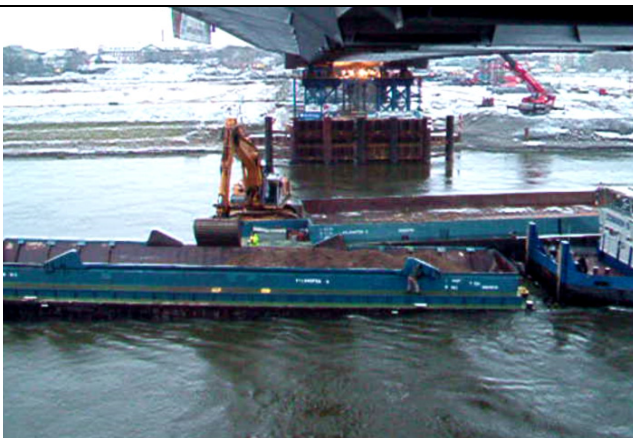
Foto 32: Entladen der Klappschute (im Vordergrund). Im Hintergrund an die Klappschute angedockt liegt der Schubverband mit dem Bagger, der im Bereich der Verklappung vorher den Elbegrund aufgeraut hat. Nachdem die Klappschute entladen ist, fuhr diese wieder zur Umladestelle an das Ufer um erneut beladen zu werden.
