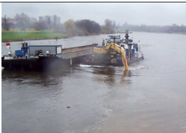
Foto 3: Aufräumen der Gewässersohle. Das Aufräumen erfolgte von oberstrom nach unterstrom.
