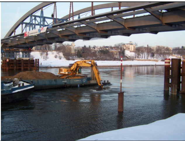
Foto 20: Aufräumen der Elbesohle vor Wiedereinbau der Massen mittels Hydraulikbagger.
