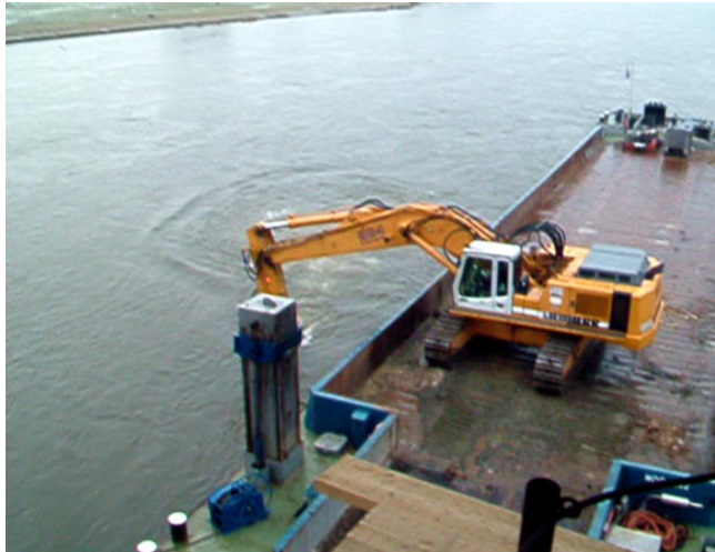
Foto 25: Aufräumen des Gewässerbodens von oberstrom nach unterstrom längs des Schubverbandes.
