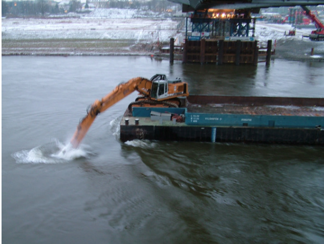
Foto 31: Schubverband mit Hydraulikbagger. Während am Ufer (außerhalb des Fotos) das Beladen der Klappschute erfolgte, wurde durch den auf dem Schubverband befindlichen Bagger die Elbesohle im Bereich der Verklappung aufgeraut. Der Schubverband blieb unbeladen, sodass der Bagger auf dessen Oberfläche frei beweglich war und in den entsprechenden Bereichen agieren konnte.
