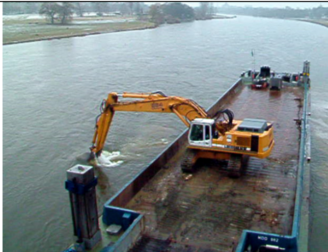
Foto 26: Aufräumen des Gewässerbodens von oberstrom nach unterstrom längs des Schubverbandes.
