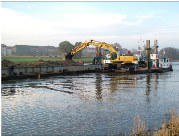
Foto 11: Beladen des Schubverbandes mit den ausgehobenen Massen.
