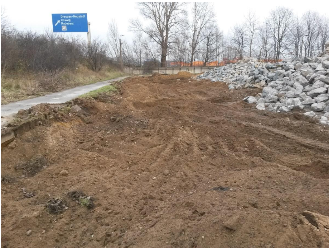
Abb. 41: im Winter: Entsiegelung durch Gebäudeabbruch und Fundamentrückbau, danach wurde der links zu sehende Weg ebenfalls zurückgebaut.
