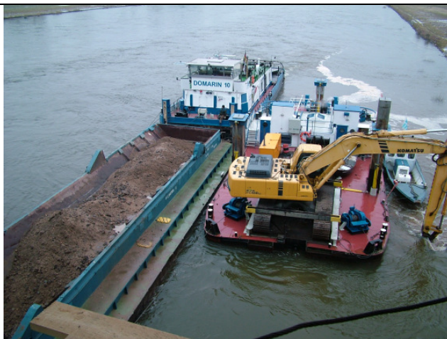
Foto 30: Beladen der Klappschute. Für den Wiedereinbau der zwischengelagerten Elbesedimente in der Fahrrinne (Schifffahrt) kam eine Klappschute zum Einsatz. Der Hydraulikbagger vom Schubverband übernahm in diesem Fall das Aufrauen der Elbesohle vor Wiedereinbau und das Planieren der eingebauten Massen am Elbegrund.
