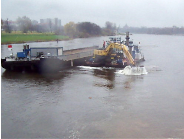
Foto 4: Aufräumen der Gewässersohle. Das Aufräumen erfolgt mit leerer Baggerschaufel.
