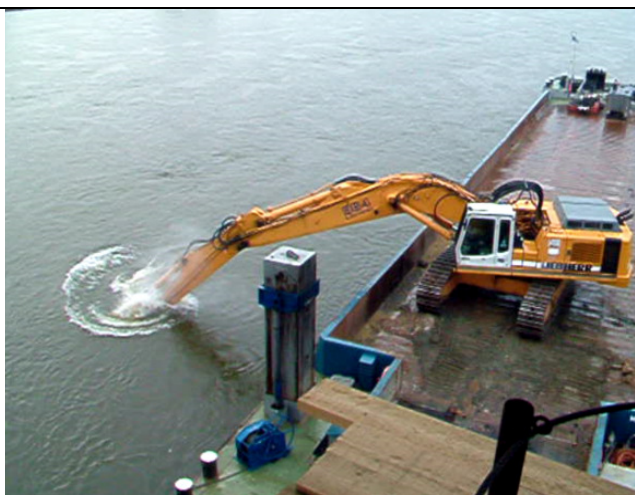
Foto 24: Außer in der Hauptfahrrinne der Schifffahrt erfolgte der Einbau mittels Hydraulikbagger. Das Bild zeigt das Aufrauen der Gewässersohle im nachfolgend angedachten Einbaubereich längs seitlich des Schubverbandes.
