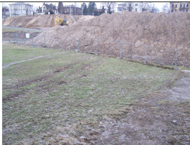
Foto 14: Zwischenlager für die ausgehobenen Massen. Der Transport erfolgte innerhalb des Baufeldes. Das Zwischenlager liegt außerhalb des Hauptabflussgebietes der Elbe, außerhalb des FFH-Gebietes und innerhalb des Baufeldes.
