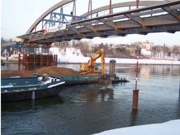
Foto 19: Aufräumen der Elbesohle vor Wiedereinbau der Massen mittels Hydraulikbagger.
