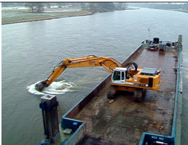
Foto 27: Aufräumen des Gewässerbodens von oberstrom nach unterstrom längs des Schubverbandes.
