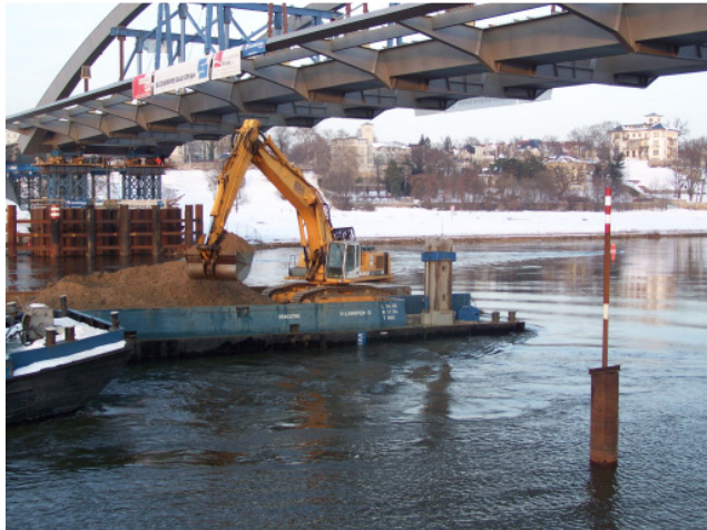
Foto 22: Einbau der Massen mittels Hydraulikbagger. Die Massen wurden vom Schubverband entnommen und in der Elbe eingebaut.
