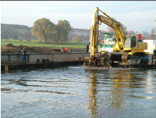
Foto 8: Beladen des Schubverbandes mit den ausgehobenen Massen.
