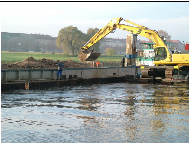
Foto 9: Beladen des Schubverbandes mit den ausgehobenen Massen.
