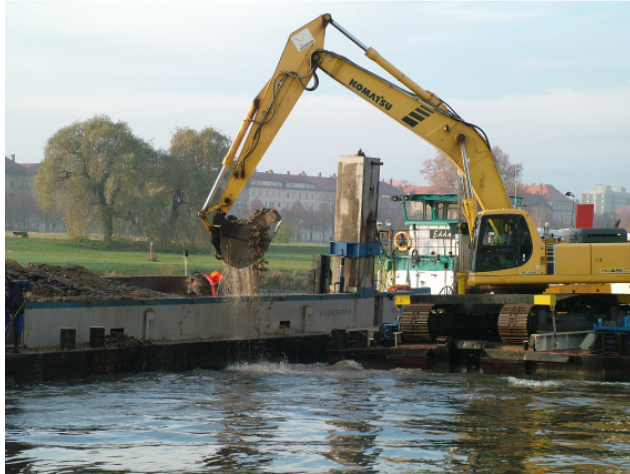
Foto 10: Beladen des Schubverbandes mit den ausgehobenen Massen.
