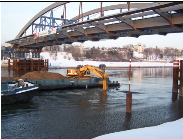
Foto 21: Aufräumen der Elbesohle vor Wiedereinbau der Massen mittels Hydraulikbagger.
