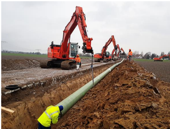
Abbildung 12: Absenken Rohrstrang
