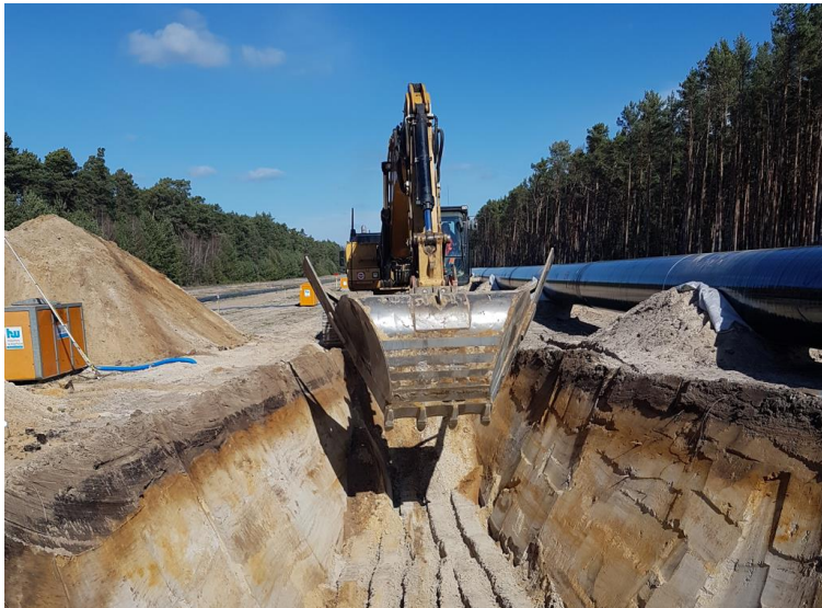
Abbildung 11: Aushub eines Rohrgrabens mittels Trapezlöffel
