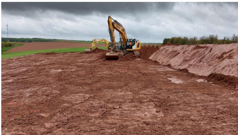
Abbildung 7: Abtrag des Oberbodens mittels Kettenbagger auf der ausgeflockten Trasse
