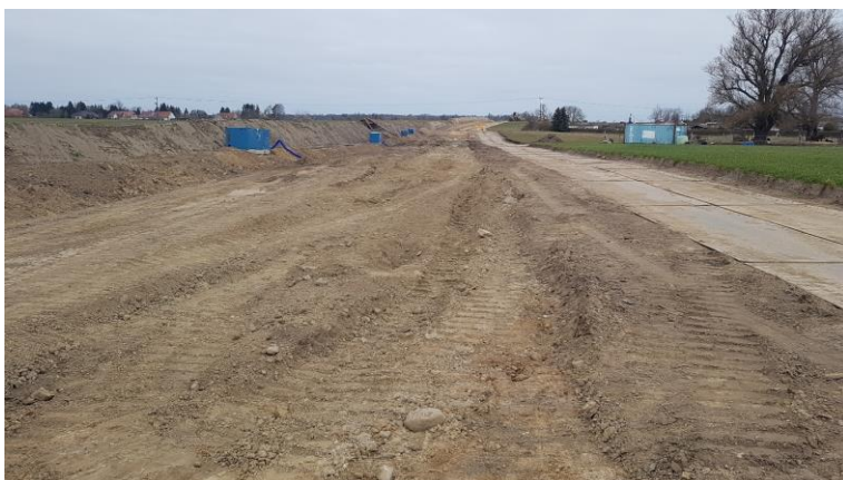
Abbildung 8: Vakuumentwässerung einer Leitungstrasse in einem Feuchtgebiet
