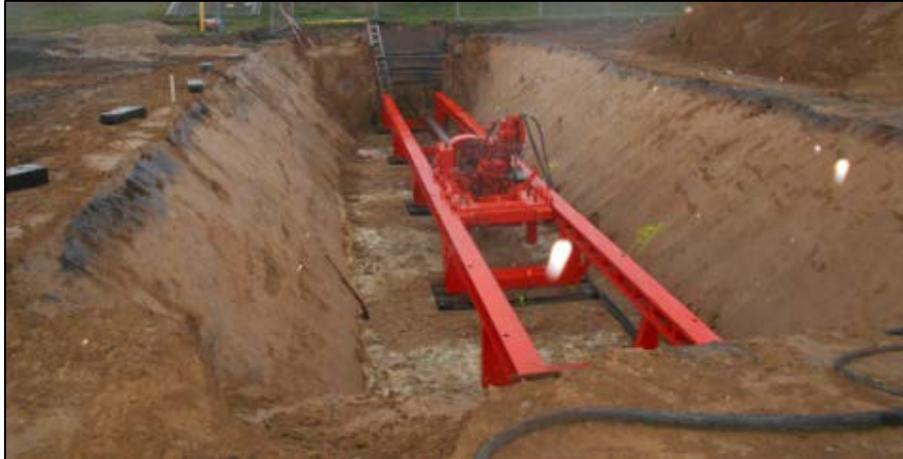
*Abbildung 34: Beispiel geschlossene Querung mittels Pilotrohrvortrieb*
