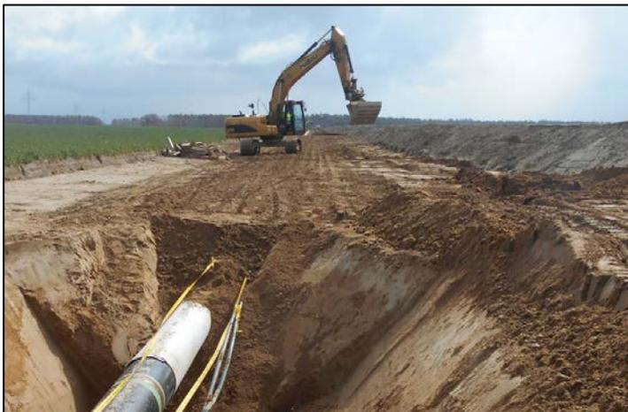
Abbildung 37: Restverfüllung des Rohrgrabens
