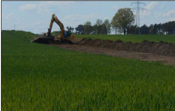
*Abbildung 38: Oberflächenwiederherstellung*
