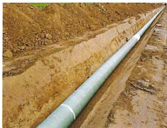
Abbildung 13: Rohrstrang auf Bettung
