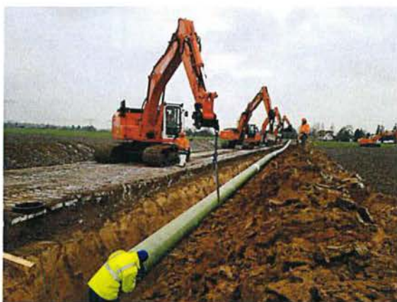
Abbildung 12: Absenken Rohrstrang
