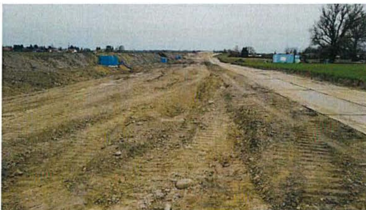
Abbildung 8: Vakuumentwässerung einer Leitungstrasse in einem Feuchtgebiet
