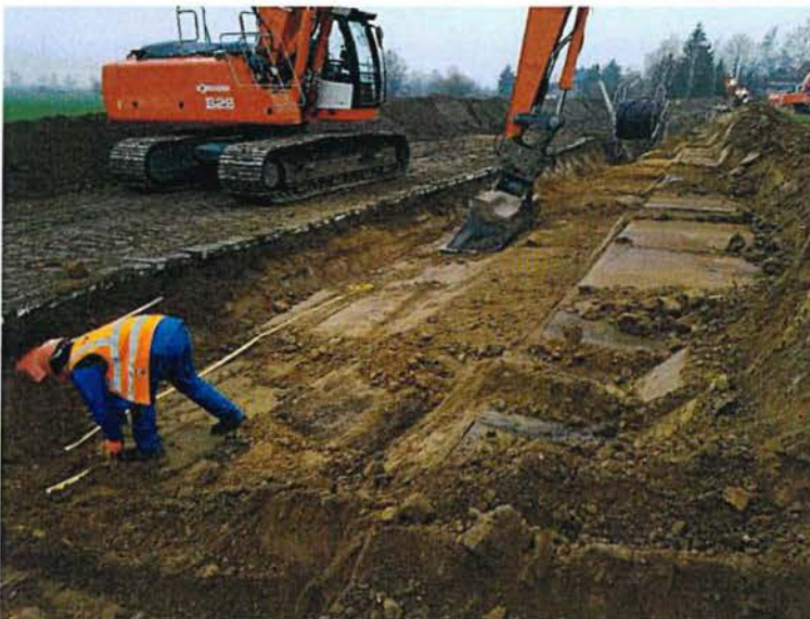
Abbildung 15: Rückverfüllung Rohrgraben und Verlegung Warnband
