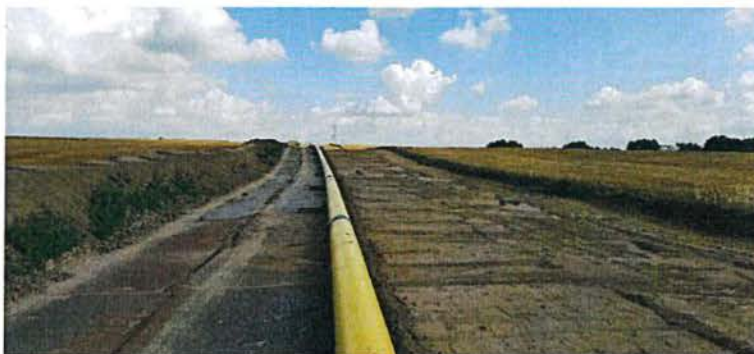
Abbildung 10: Vorgestreckter und verschweißter Rohrstrang
