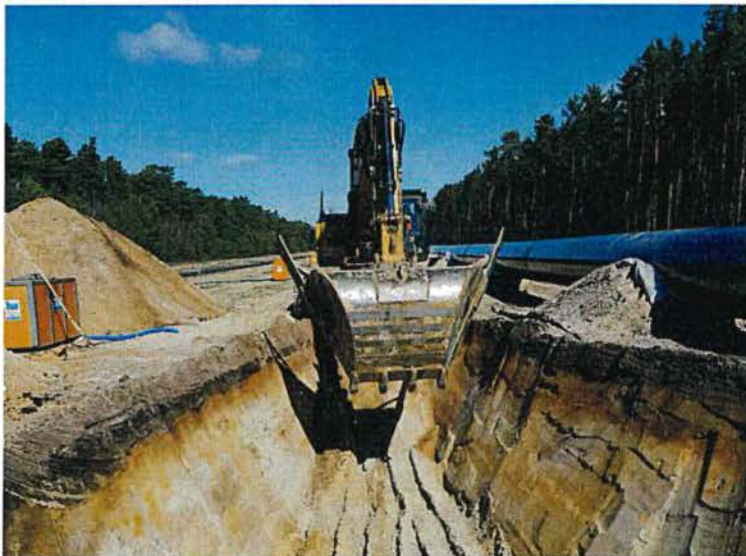
Abbildung 11: Aushub eines Rohrgrabens mittels Trapezlöffel
