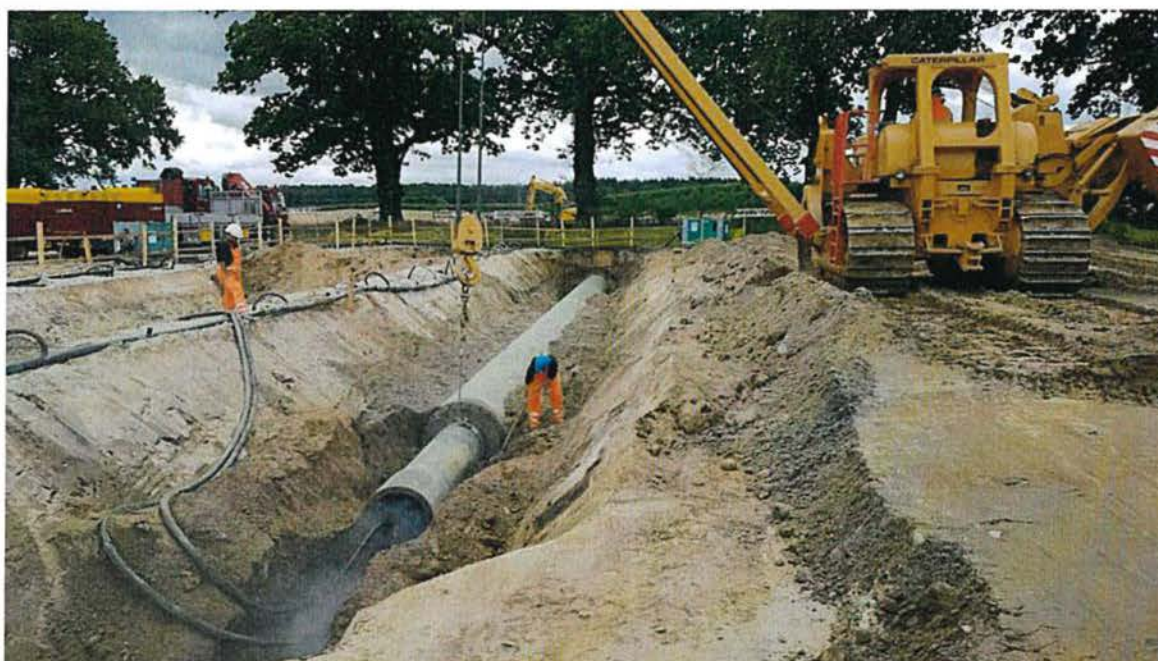
Abbildung 14: Beispiel eines Mantelrohrvortriebs im Horizontal-Pressverfahren
