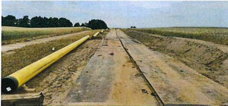
Abbildung 9: Ausfahren der Rohre und Ablegen auf Lagerhölzer neben dem Rohrgraben
