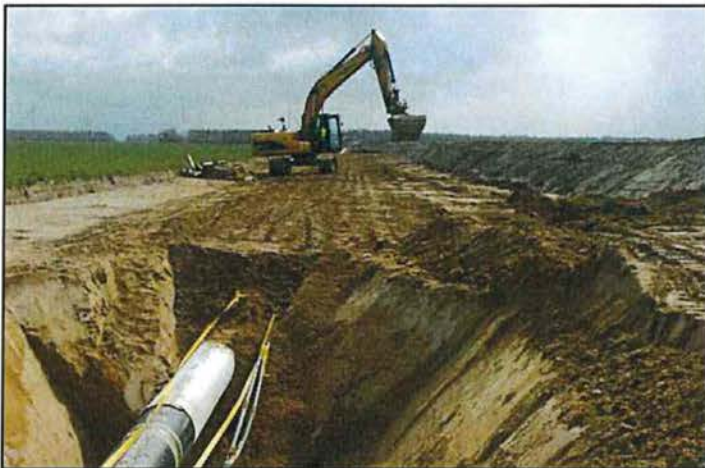
Abbildung 37: Restverfüllung des Rohrgrabens
