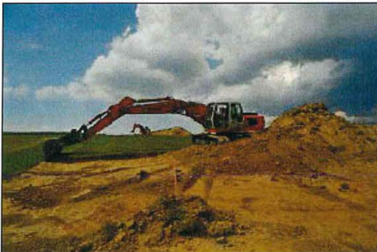
Abbildung 32: Abtrag Oberboden
