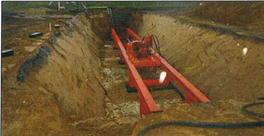
Abbildung 34: Beispiel geschlossene Querung mittels Pilotrohrvortrieb
