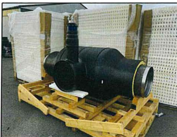
Abbildung 16: Beispiel - vorisolierter KMR-KH mit 3S-Antrieb
