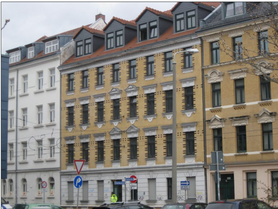
Abb. 6 Straßenansicht und Lage - Gebäude Gorkistraße 29
