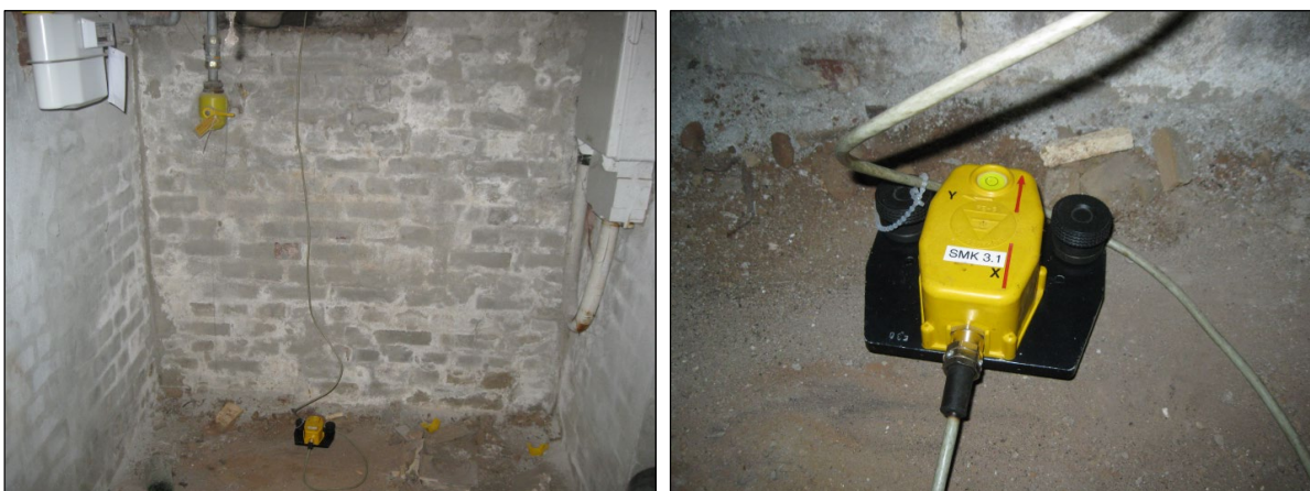
Abb. 7 Messaufnehmer am Gebäudefundament (Keller straßenseitig, MP 1 x/y/z Gebäude)
