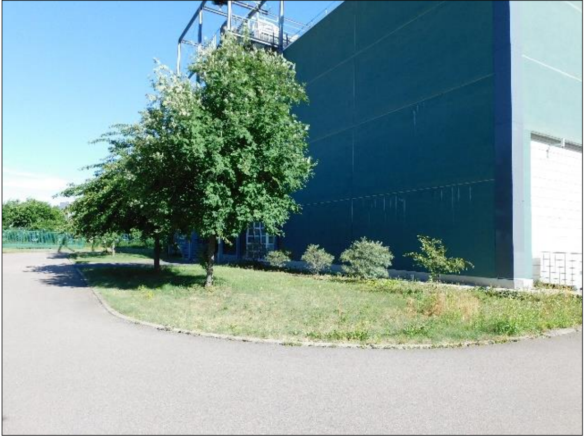
Abbildung 4: Blick in Richtung Westen auf die Fläche für den Anbau an das EVC 2
