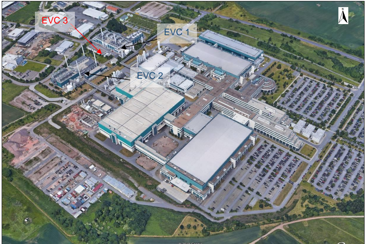
Abbildung 2: Luftbild vom Standort mit Kennzeichnung des Geländes der EVC
