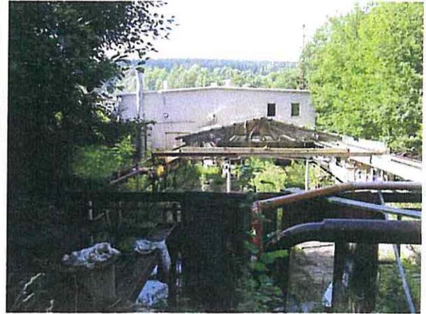
Abb. B 17: Ehemalige Anlagen der Fischzuchtanlage Schönfeld; nach dem Abbruch der Anlagen (Maßnahme A 1) sind die Entwicklung eines Auenwales und gelenkte Sukzession vorgesehen (Maßnahme A 2); bei dem Gehölzsaum rechts im Bild handelt es sich um den Ufergürtel der Zschopau 1
