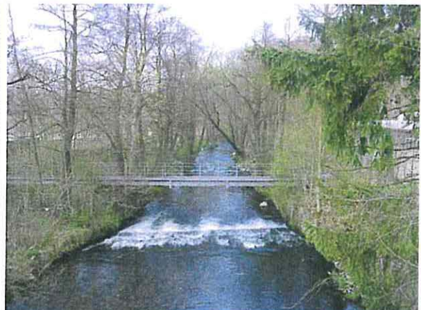
Abb. B 15: Zschopau östlich der bestehenden Brücke der B 95; die Areale etwa bis zum Steg werden überbaut (Konflikt K_{Bo3} ); der Ufergehölzgürtel geht verloren (Konflikt K_{Bio3} ), wird teilweise aber wieder angepflanzt (Maßnahme A 8) 4
