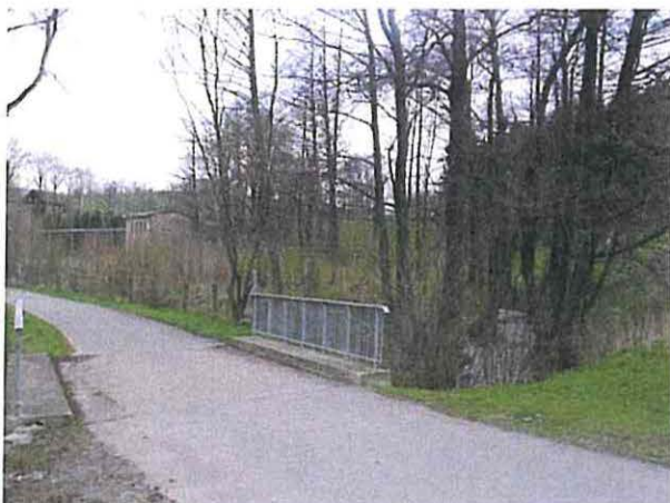
Abb. B 69: Unterer Tannenberger Straße und Greifenbach in Tannenberg aus Richtung Westen 4
