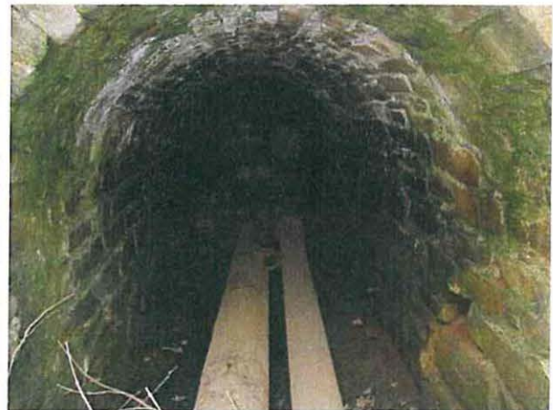
Abb. B 42: Einer der Leitungstunnel im Gebiet, hier südwestlich der Sehmabücke der Tannenberger Straße, die Tunnel weisen ebenso wie die Straßenbrücke potenzielle Spaltenverstecke auf 4
