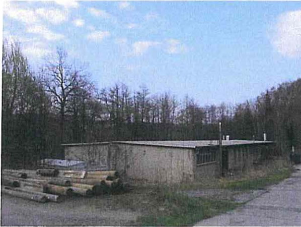
Abb. B 16: Hauptgebäude der ehemaligen Fischverarbeitung; der Abbruch erfolgt im Zuge Straßenbaus zur Errichtung von Brückenpfeilern (Maßnahme A 1) 4
