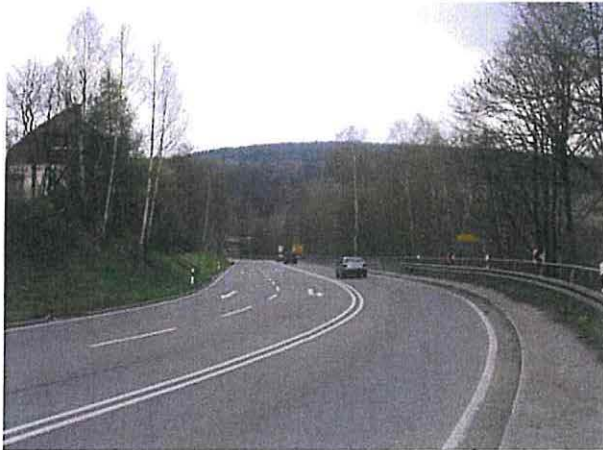
Abb. B 22: Rampe der B 95 am südlichen Zschopauhang; die Trasse wird hier zur Gemeindestraße rückgestuft; die rechte Fahrbahnhälfte wird rückgebaut (Maßnahme A 1) und begrünt (Maßnahmen A 4 und A 5) 4
