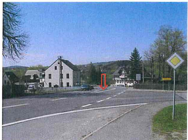
Abb. B 27: Bisheriger Einmündungsbereich der Bahnhofstraße (K 7111) in die B 95; in der Bildmitte (Pfeil) die Brücke der B 95 über die Bahnlinie Flöha-Bärenstein 2
