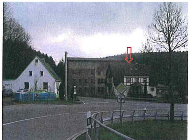
Abb. B 21: Kreuzung der B 95 mit den Staatsstraßen aus Richtung Nordosten mit Blick zum denkmalgeschützten Wohnhaus der ehemaligen OPEW (Pfeil) 4
