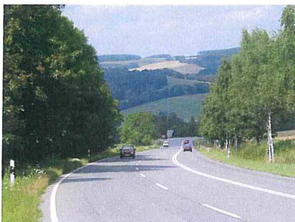
Abb. B 37: B 95 am Bauende mit Blick Richtung Norden; durch die Neuprofilierung von Böschungen und Mulden (Konflikt K_{Bo2} ) wird auch die Baumreihe (Konflikt K_{Bio1} ; rechts im Bild) gerodet; es erfolgen Neupflanzungen an gleicher Stelle (Maßnahme A 3); vorübergehend beanspruchter Acker (Konflikt K_{Bio7} ) entsteht vor Ort neu (Maßnahme A 10) 1
