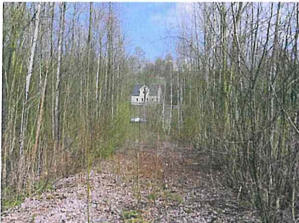
Abb. B 49: Rückgebaute Bahntrasse zur Papierfabrik, hier zwischen Sehma und B 95 (im Bild hinten) 4
