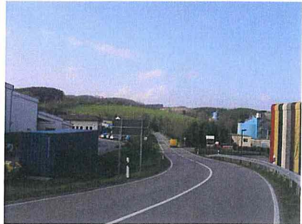
Abb. B 11: Talstraße (S 261) in Richtung Wiesa, zum Gewerbegebiet (links) und zur Straßenmeisterei (vorn rechts) werden Stützwände errichtet 4
