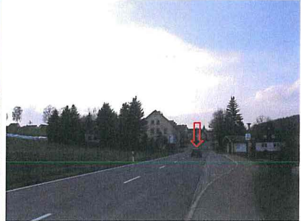
Abb. B 2: Bauanfang der B 95 (Pfeil) im Bereich der Bushaltestelle Schönfeld mit Blick Richtung Norden; hier erfolgt die Anbindung der neuen Trasse an den Bestand 4
