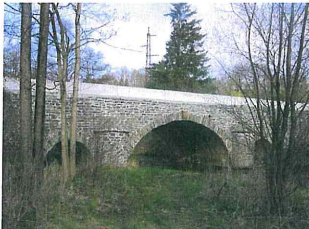
Abb. B 14: Zschopaubrücke der B 95 aus Richtung Westen; im Bereich wird der Überlaufgraben des geplanten Regenklärbeckens (Maßnahme V 2) in die Zschopau geführt (Konflikt K_{Bio8} , K_{W1} ) 4
