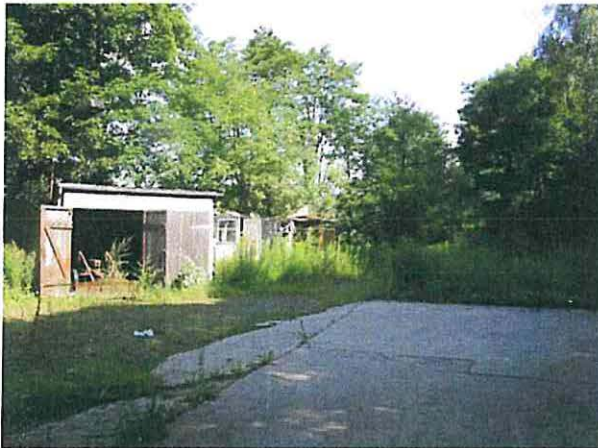
Abb. B 18: Schuppen, versiegelte und teilversiegelte Bereiche der ehemaligen Fischverarbeitung Schönfeld; auf diesen Flächen wird die Ausgleichsmaßnahme A 2 umgesetzt 1
