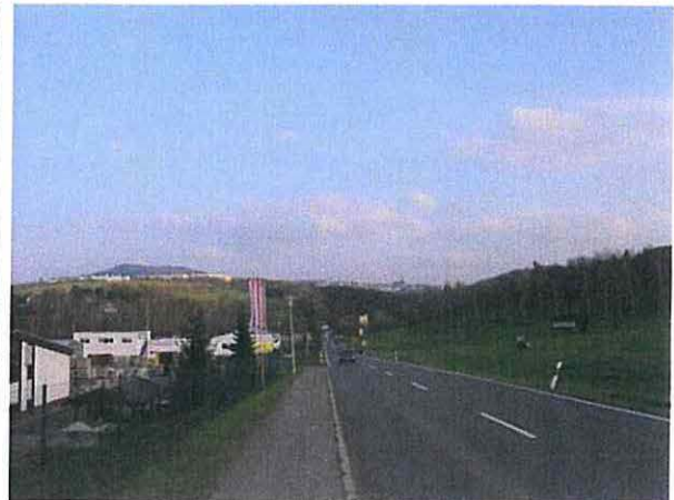
Abb. B 5: Aktueller Verlauf der B 95 mit Blick Richtung Annaberg; links im Bild das Gewerbegebiet Schönfeld, der Abschnitt im Bildvordergrund wird rückgebaut (Maßnahme A 1) und die B 95 nach Osten (im Bild rechts) verschoben 4
