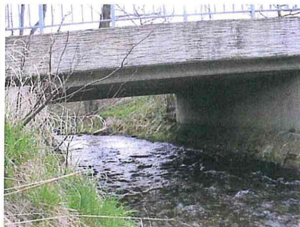
Abb. B 70: Brücke der Unterer Tannenberger Straße über den Greifenbach in Tannenberg aus Richtung Süden; hier wird ein Wasseramselekasten angebracht (Maßnahme E 2) 4
