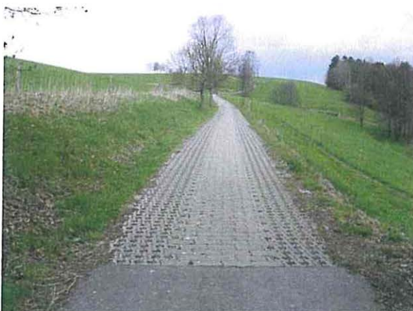
Abb. B 71: Unterer Tannenberger Straße in Schönfeld an der Ortsgrenze zu Tannenberg aus Richtung Westen; rechts des Weges ist die Pflanzung einer Baumreihe vorgesehen (Maßnahme A 9) 4
