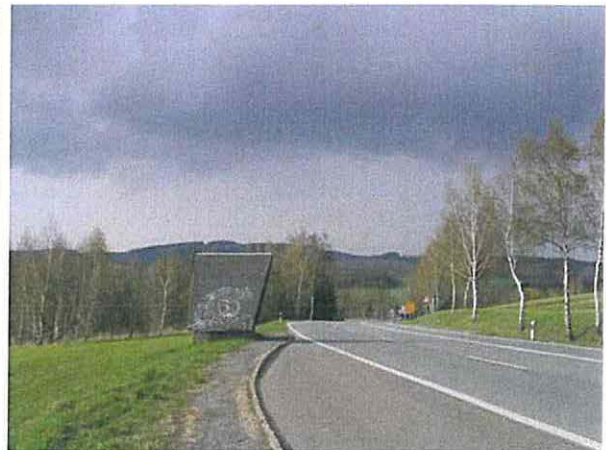
Abb. B 31: B 95 südlich Wiesa; die bestehende Busbucht wird rückgebaut (Maßnahme A 1); südlich des dargestellten Abschnitts schwenkt die neue B 95 nach Westen (im Bild links) ab 4
