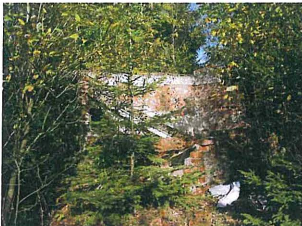
Abb. B 79: Auf der auch „Marie“ genannten Fläche in Hundshübel werden Reste kleinerer Gebäude abgebrochen (Maßnahme E 6) 5
