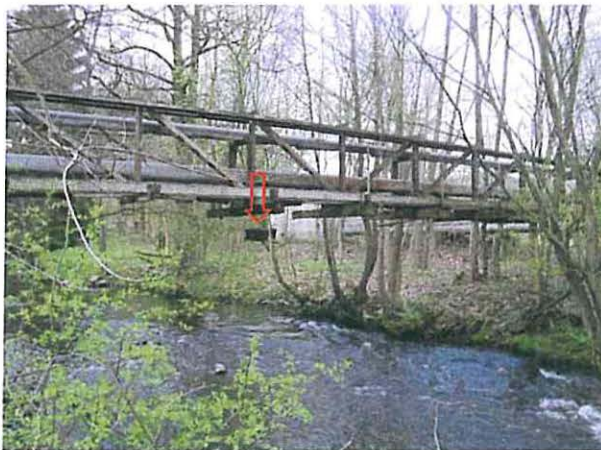
Abb. B 41: Eine der alten Heizleitungstrassen im Gebiet, hier über die Zschopau westlich der Brücke der B 95; der Pfeil markiert eine Nisthilfe 4
