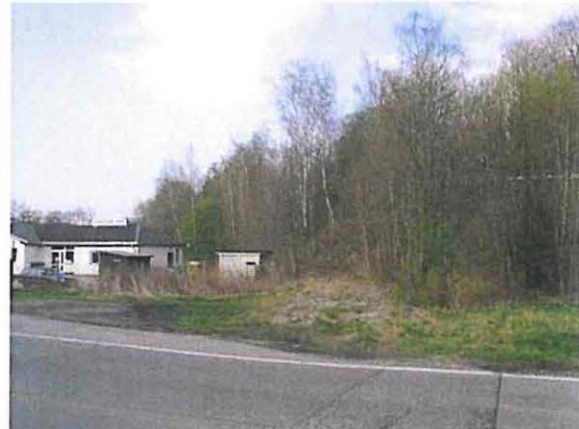
Abb. B 19: Fischverkauf Schönfeld und ehemalige Bahntrasse zur Papierfabrik, Teile des Hangwaldes werden für die neue Großbrücke gerodet (Konflikte K_{Bo3} , K_{Bio3} ) 4
