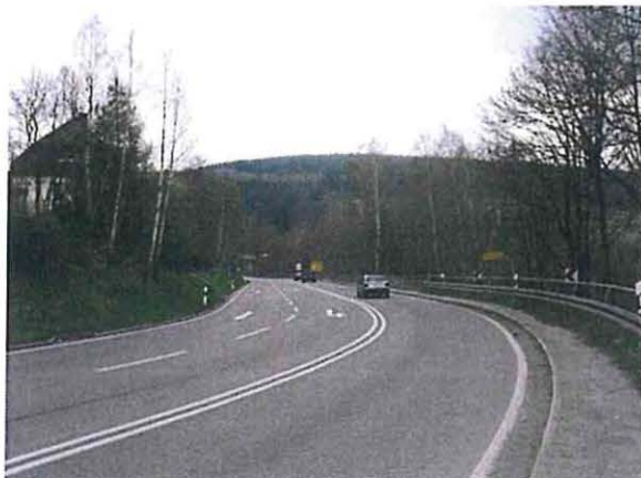
Abb. B 22: Rampe der B 95 am südlichen Zschopauhang; die Trasse wird hier zur Gemeindestraße rückgestuft; die rechte Fahrbahnhälfte wird rückgebaut (Maßnahme A 1) und begrünt (Maßnahmen A 4 und A 5) 4
