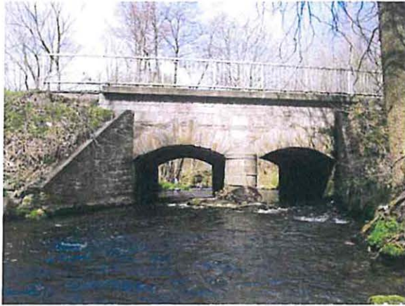
Abb. B 45: Brücke der Tannenberger Straße (S 260) über die Sehma 4
