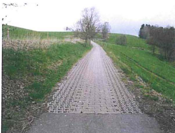
Abb. B 71: Untere Tannenberger Straße in Schönfeld an der Ortsgrenze zu Tannenberg aus Richtung Westen; rechts des Weges ist die Pflanzung einer Baumreihe vorgesehen (Maßnahme A 9) 4
