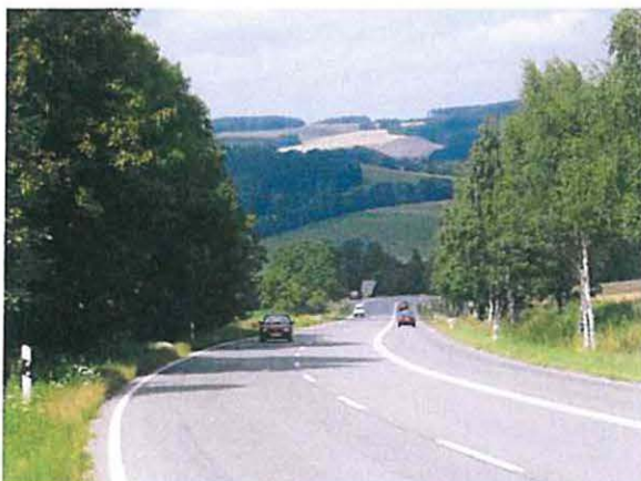
Abb. B 37: B 95 am Bauende mit Blick Richtung Norden; durch die Neuprofilierung von Böschungen und Mulden (Konflikt K Bio2 ) wird auch die Baumreihe (Konflikt K Bio1 ; rechts im Bild) gerodet; es erfolgen Neupflanzungen an gleicher Stelle (Maßnahme A 3); vorübergehend beanspruchter Acker (Konflikt K Bio7 ) entsteht vor Ort neu (Maßnahme A 10) 1
