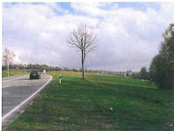
Abb. B 38: Blick vom Bauende in Richtung Annaberg; rechts im Bild, verdeckt hinter den Gehölzen, befindet sich das Weißgut; in diesem Bereich werden Wildwarnreflektoren angebracht (Maßnahme V 6) 4
