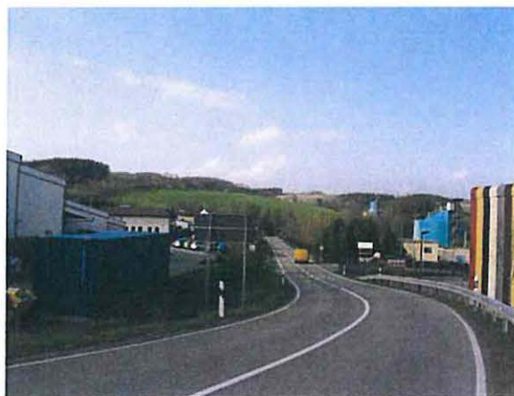
Abb. B 11: Talstraße (S 261) in Richtung Wiesa, zum Gewerbegebiet (links) und zur Straßenmeisterei (vorn rechts) werden Stützwände errichtet 4
