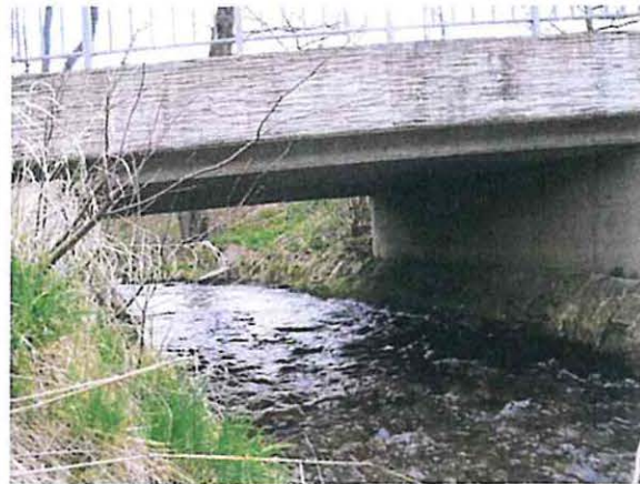
Abb. B 70: Brücke der Unteren Tannenberger Straße über den Greifenbach in Tannenberg aus Richtung Süden; hier wird ein Wasseramselkasten angebracht (Maßnahme E 2) 4
