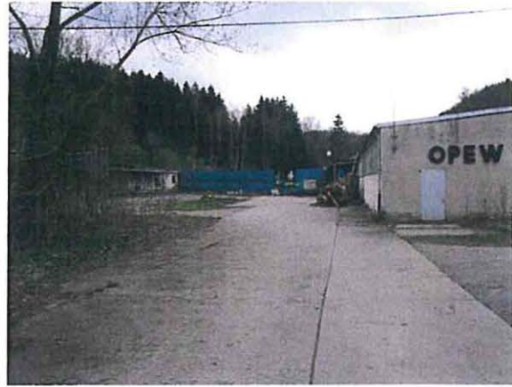
Abb. B 46: Der ehemalige OPEW-Standort im Sehmatal südwestlich der Kreuzung B 95 / S 260 / S 261 4
