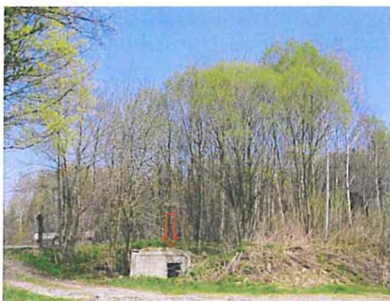
Abb. B 13: Abschnitte dieses Gehölzes nördlich der Zschopau werden durch die geplante Großbrücke überbaut (Konflikte K_{B03} , K_{Bio3} ), der Pfeil markiert den Tunnel einer Abwasserdruckleitung 3
