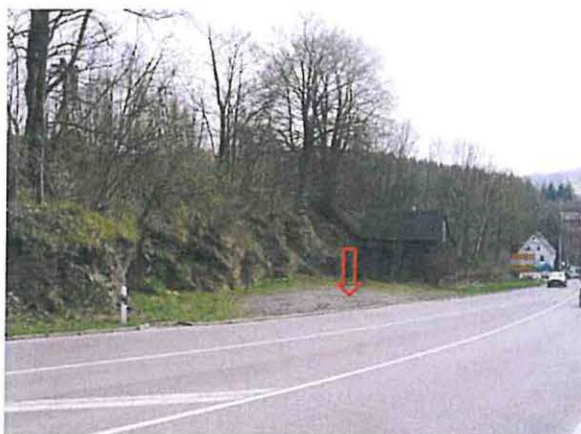
Abb. B 24: Rampe der B 95 am südlichen Zschopauhang; der Pfeil kennzeichnet einen Pfeilerstandort; der Schuppen im Bild und die rechte Fahrbahnhälfte werden rückgebaut (Maßnahme A 1) und mit Gras-/ Staudenfluren (Maßnahme A 5) sowie Hecken-/ Waldrandabschnitten (Maßnahme A 8) begrünt 4
