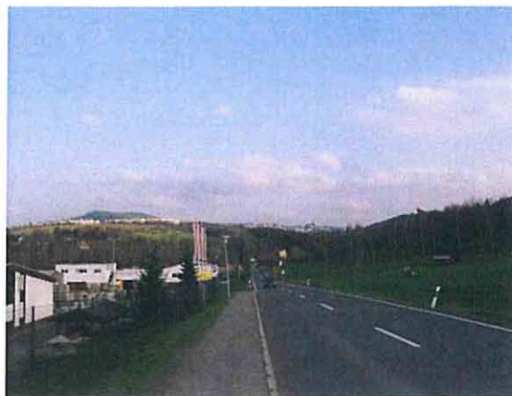
Abb. B 5: Aktueller Verlauf der B 95 mit Blick Richtung Annaberg; links im Bild das Gewerbegebiet Schönfeld, der Abschnitt im Bildvordergrund wird rückgebaut (Maßnahme A 1) und die B 95 nach Osten (im Bild rechts) verschoben 4
