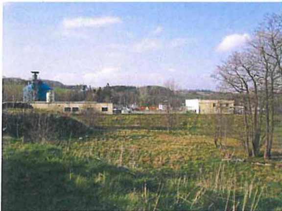
Abb. B 53: Feuchtwiese bzw. Staudenflur (§ 26- Biotop) zwischen Kläranlage (hinten im Bild) und Fischzuchtanlage Schönfeld 4
