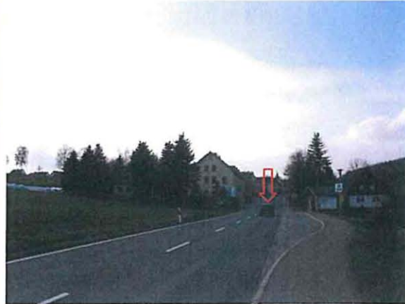
Abb. B 2: Bauanfang der B 95 (Pfeil) im Bereich der Bushaltestelle Schönfeld mit Blick Richtung Norden; hier erfolgt die Anbindung der neuen Trasse an den Bestand 4
