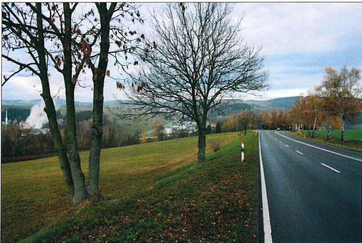
Abbildung 4: B 95 nördlich Annaberg, Blickrichtung Norden, Entwässerungsabschnitt 2.
