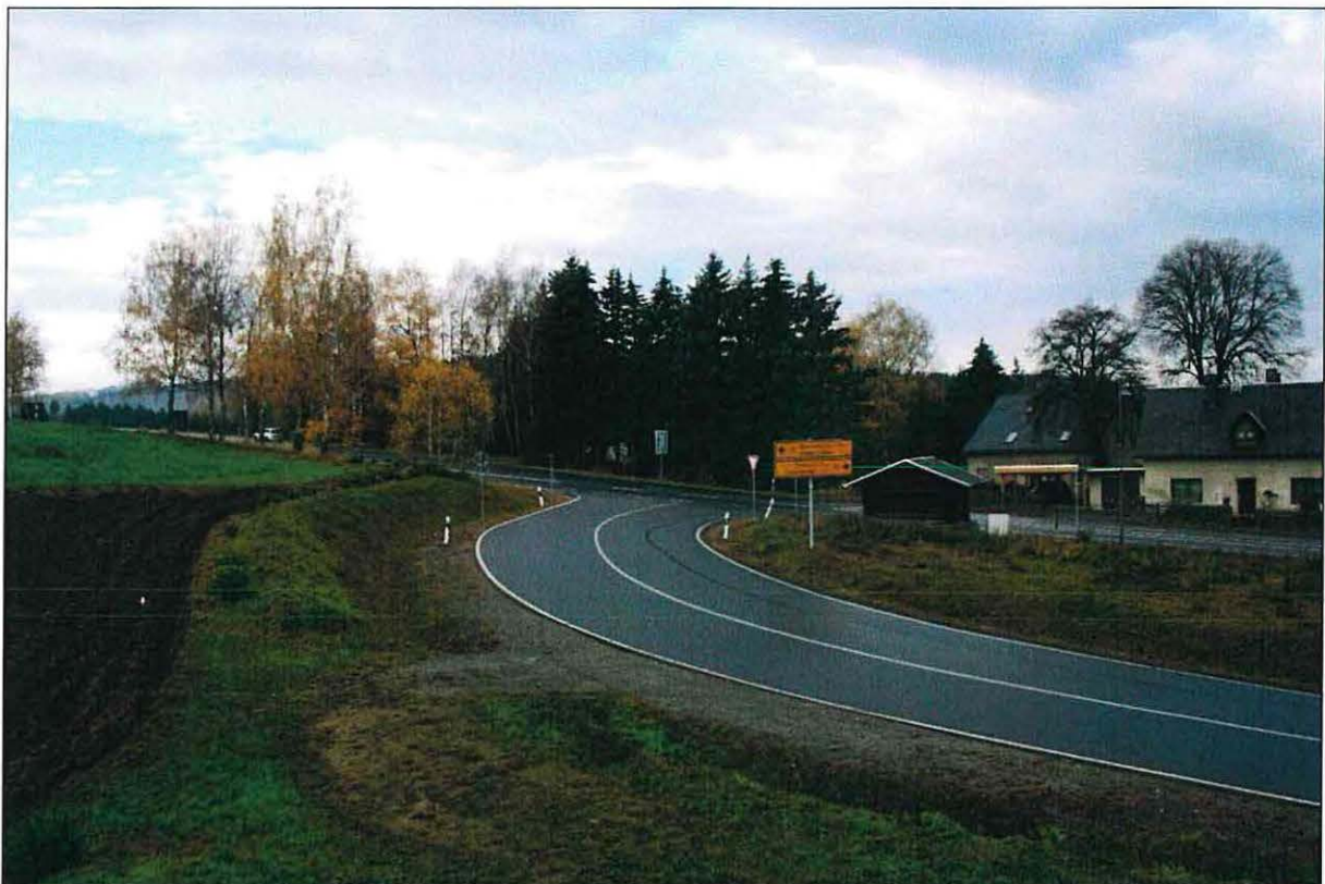
Abbildung 5: B 95 nördlich Annaberg, Blickrichtung Süden, Entwässerungsabschnitt 2, K7111 mit Mulde/Graben im Vordergrund
