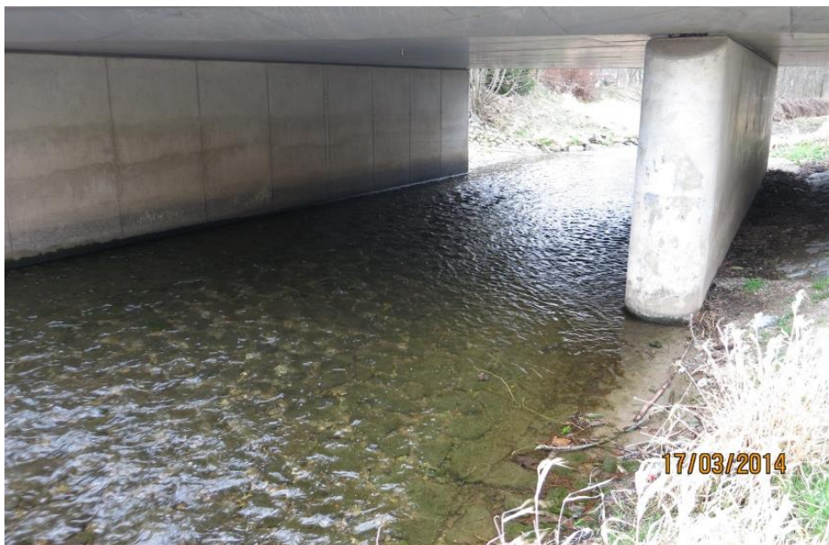
Abb. 4: vorhandene Sohlpflasterung unter Bw 2
