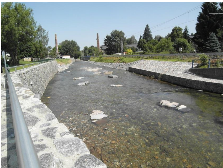
Abb. 5: Würschnitz kurz oberhalb der Messstelle Biologie am 18.6.2013, nachdem im November 2012 die Hochwasserschutzmaßnahme M 1.7 Würschnitz incl. Sohlstrukturierung abgeschlossen wurde und Ende Mai/Anfang Juni 2013 ein größeres Hochwasserereignis stattfand
