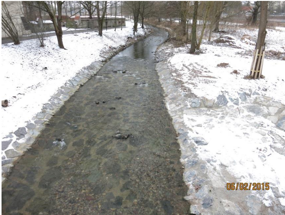
Abb. 3: vorhandene Sohlpflasterung im Bereich Bw 1
