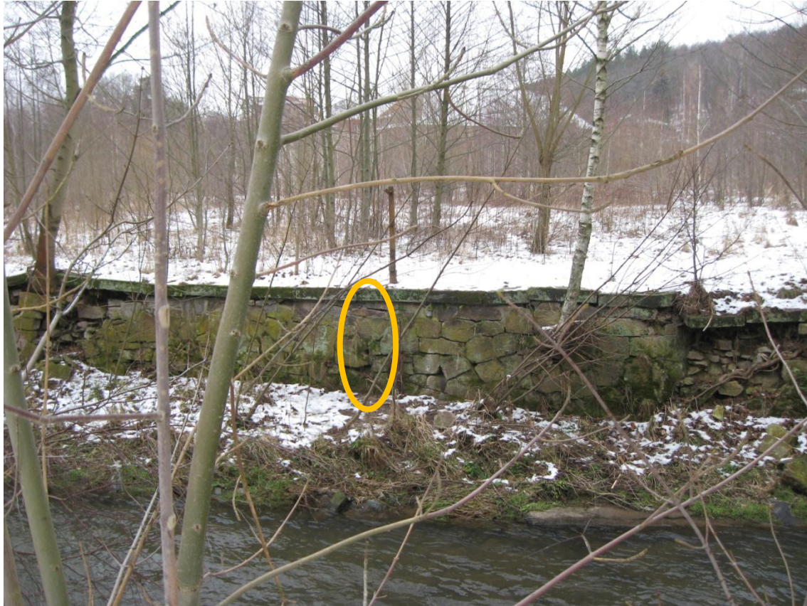
Ansatzpunkte der Mauerwerksbohrungen 1.8 MW 1 und 2
