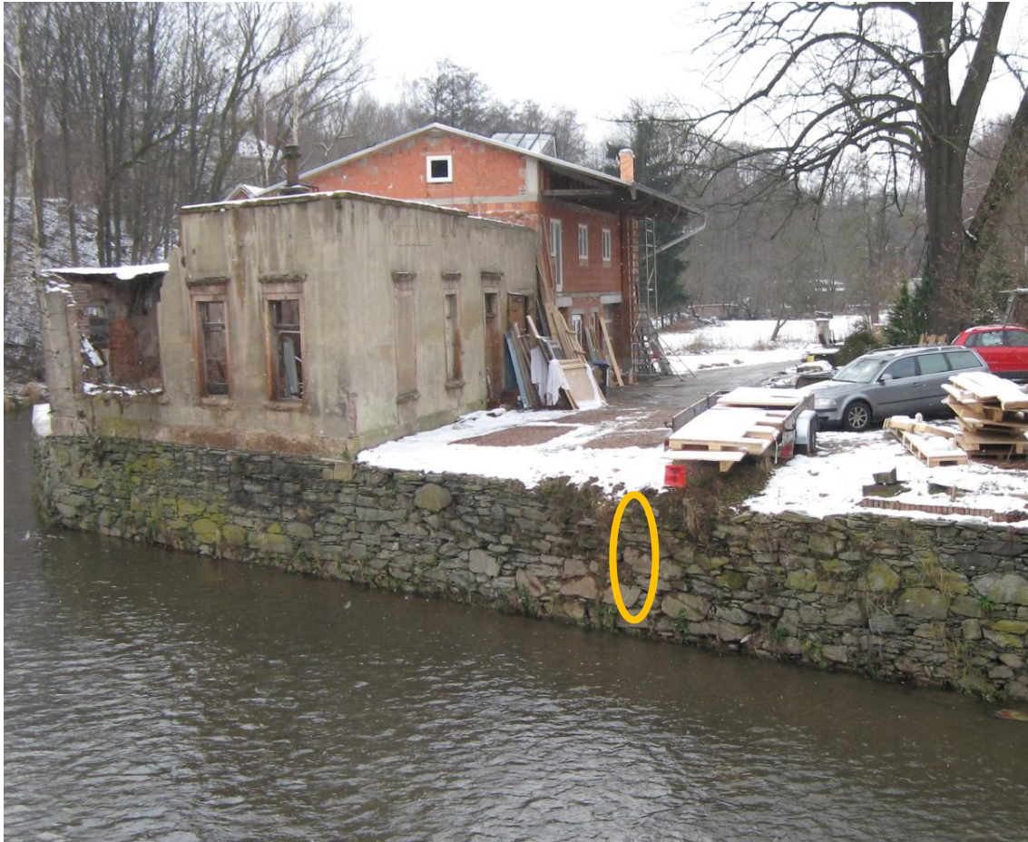
Ansatzpunkte der Mauerwerksbohrungen 1.2 MW 1 bis 3
