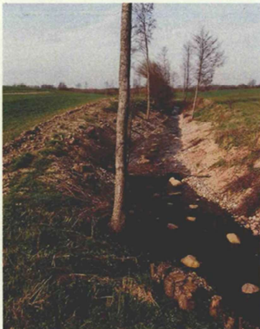
Abbildung 4: flächiger Einbau inklusive Lesesteine (Strömunglenker) und Totholz
