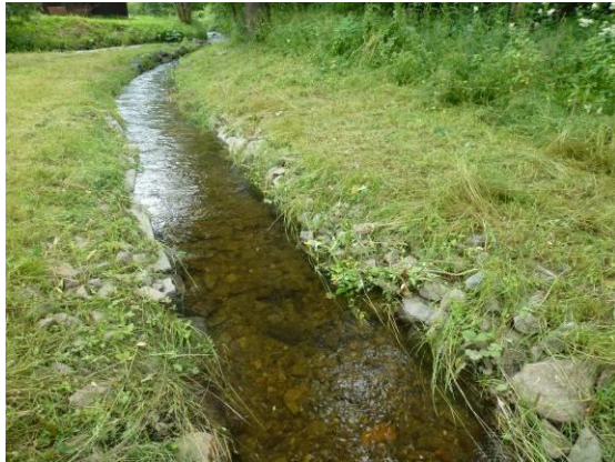
Foto 3: Östlicher Flutgraben mit Gesteinsschüttung
